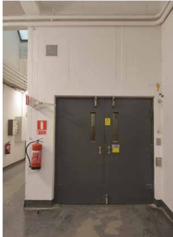
Interiör från F.d. Nordiska yllefabriken. Byggnaden är på flera ställen välbevarad invändigt.
