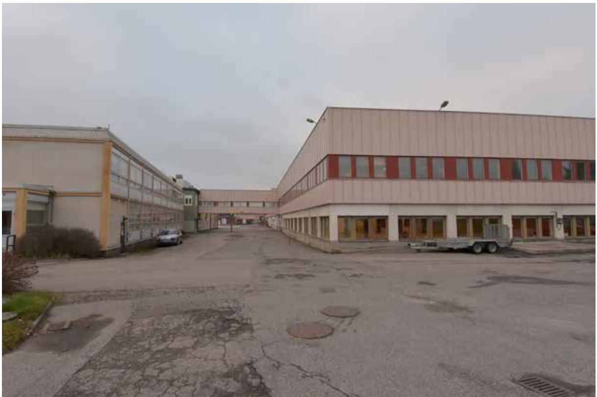
Anläggningen sedd från sydost. Till höger i bild NEFA-anläggningens södra flygel som efterhand har blivit sammanbyggd till en enda fasad. Till vänster i bild kontorsbyggnad 3.
