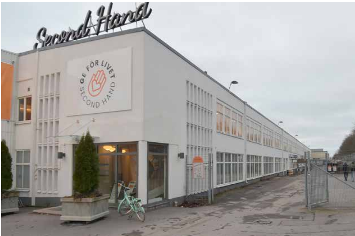
Entréparti till Nordiska yllefabriken.
