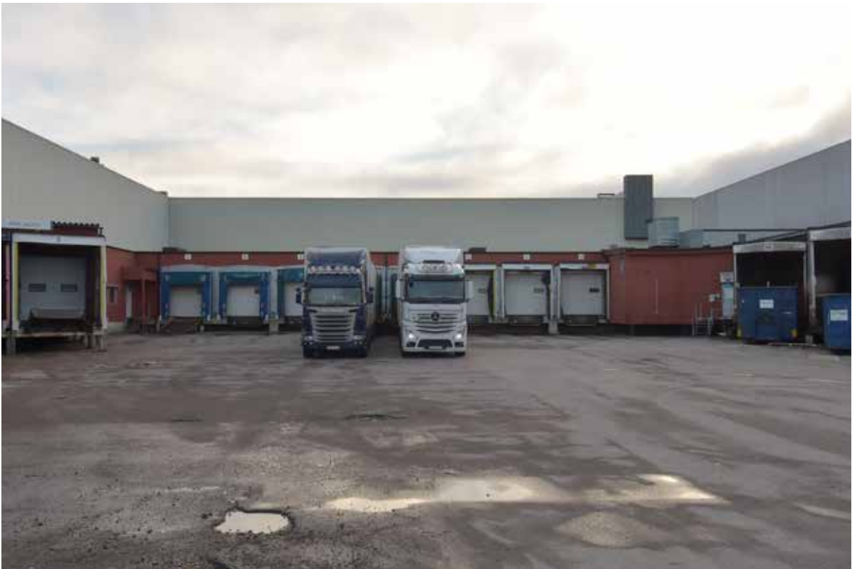
Lastkajer, i anläggningens norra del. Dessa är relaterade till centrallagrets tillkomst på 1970-talet
