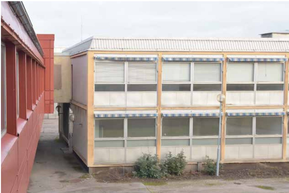
Kontorsbyggnad 1 och förbindelsegången från kontorsbyggnad 3.
