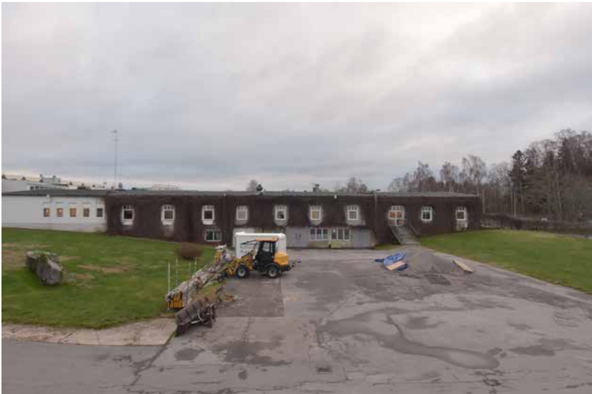
F.d. matsalen sedd från väster. I källarutrymmet fanns tidigare ett snickeri.
