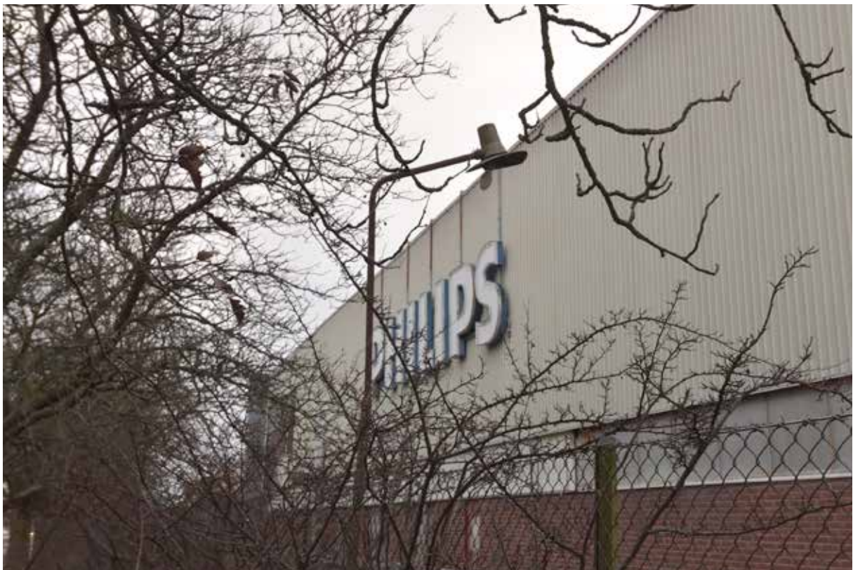
Fasad mot Finspångsvägen. Lagerbyggnad uppförd runt 1970
