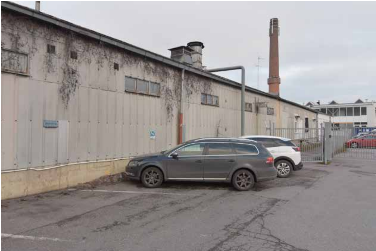
F.d. matsalen. Östra fasaden
