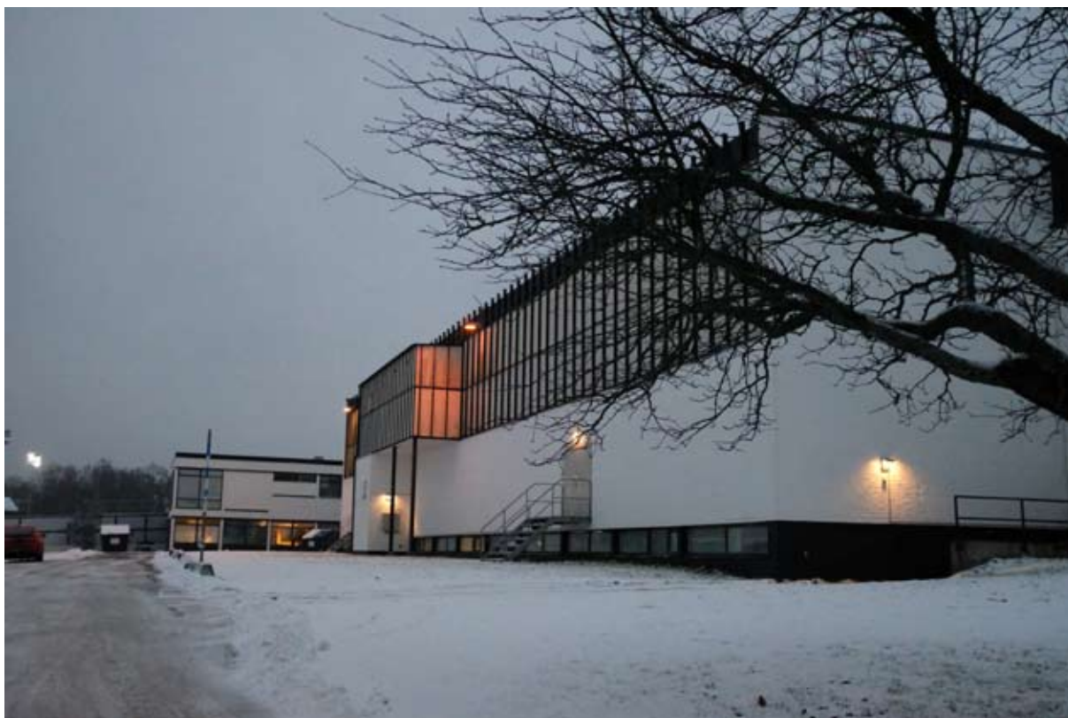
Mässhallen ritad av Jaenecke Samuelsson och uppförd till utsällningen NU64. Foto 2018
