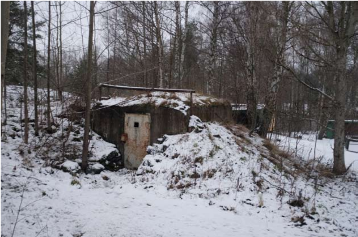
I norra delen av norra Himmelstalund finns militära fortifikationer från andra världskriget. Tre militärbaracker stod i skogen fram till 1947 men de karterades aldrig. Ur ett kulturhistoriskt perspektiv så är dessa lämningar intressanta då de skapar ett försvarshistoriskt sammanhang med resterna av skansen i Borg och det fasta huset på Ringstadholm. Foto 2018
