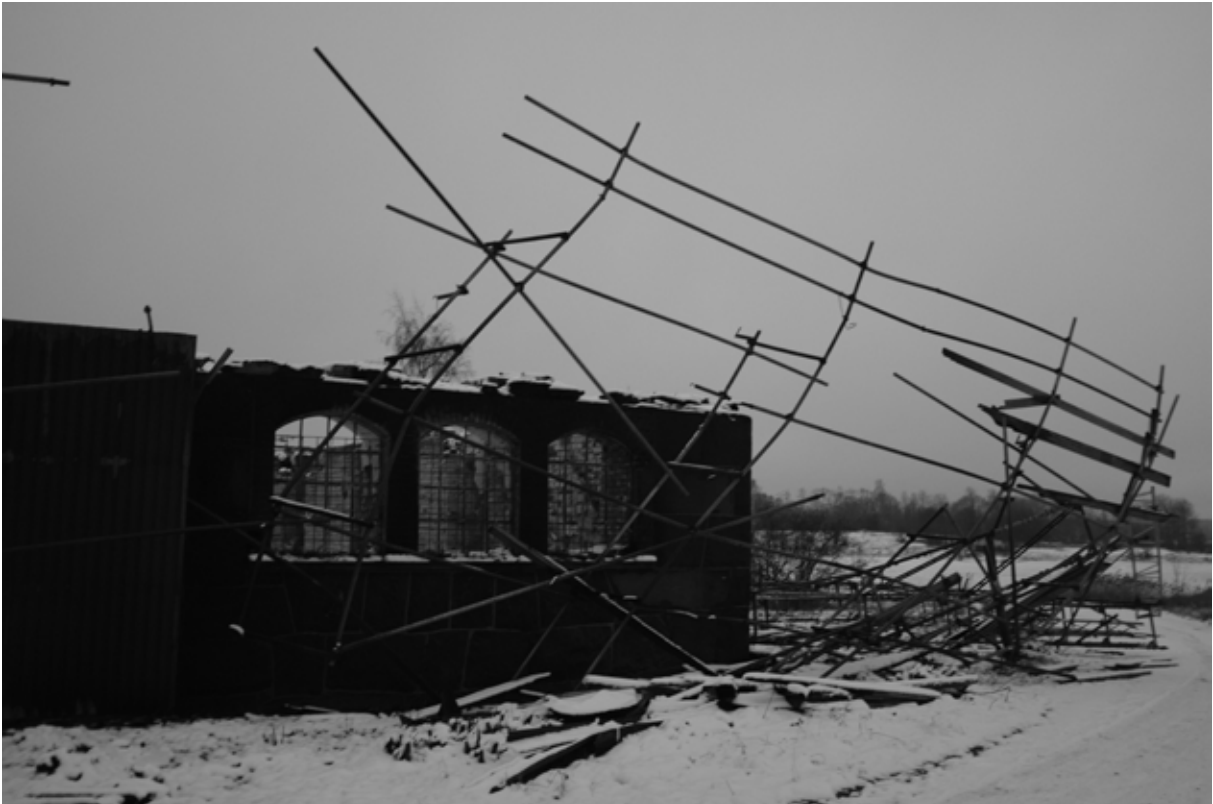
Borgs säteri hade en firsidig fägård, av denna fanns en halv ekonomilänga kvar fram till 2018 då den brann. Denna ekonomibyggnad var uppförd av lokal sten och troligen även lokalt tillverkat tegel. Foto 2018
