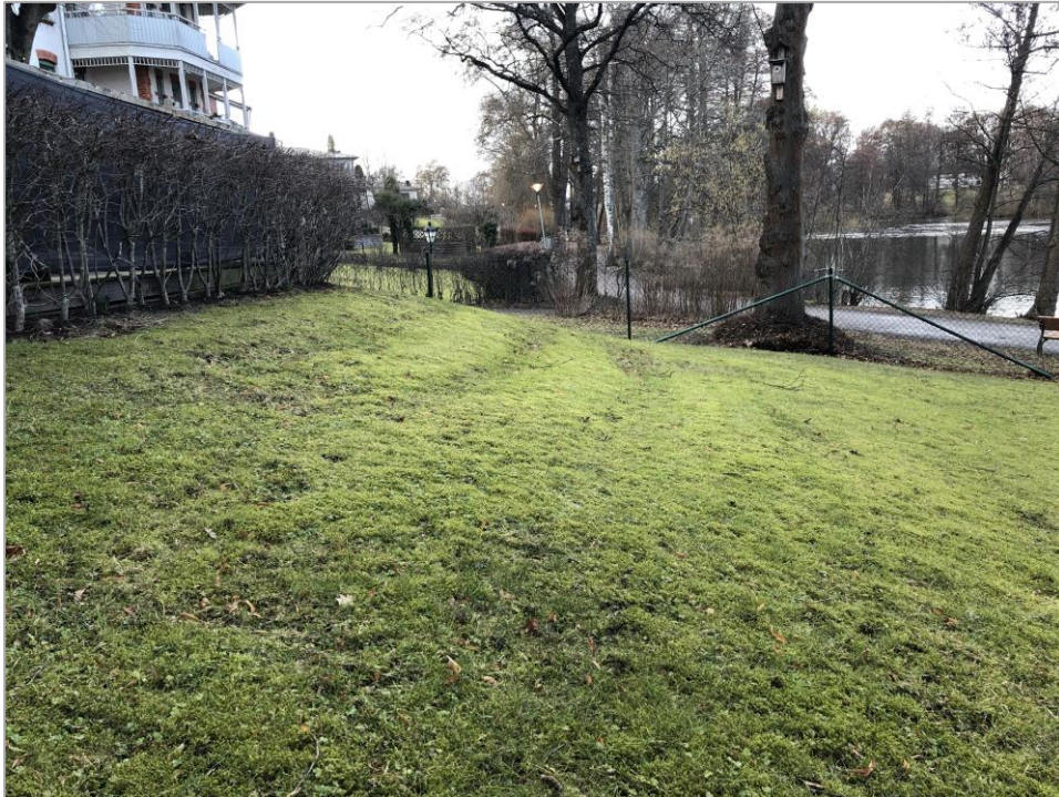
Figur B-7. Svaga fördjupningar i gräsmattan som kan tyda på dålig packning.
