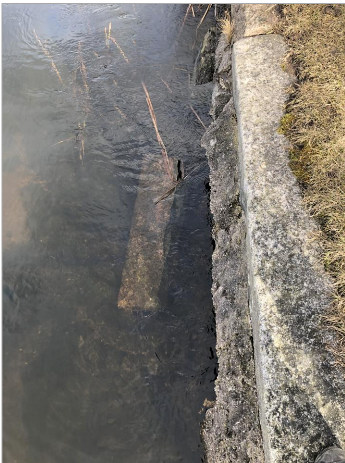
Figur B-8. Stensättning längs strandkanten i anslutning till planområdet. En sten har lossnat och ligger på botten, vilket kan tyda på dålig stensättning // dålig packning av bakfyllning.
