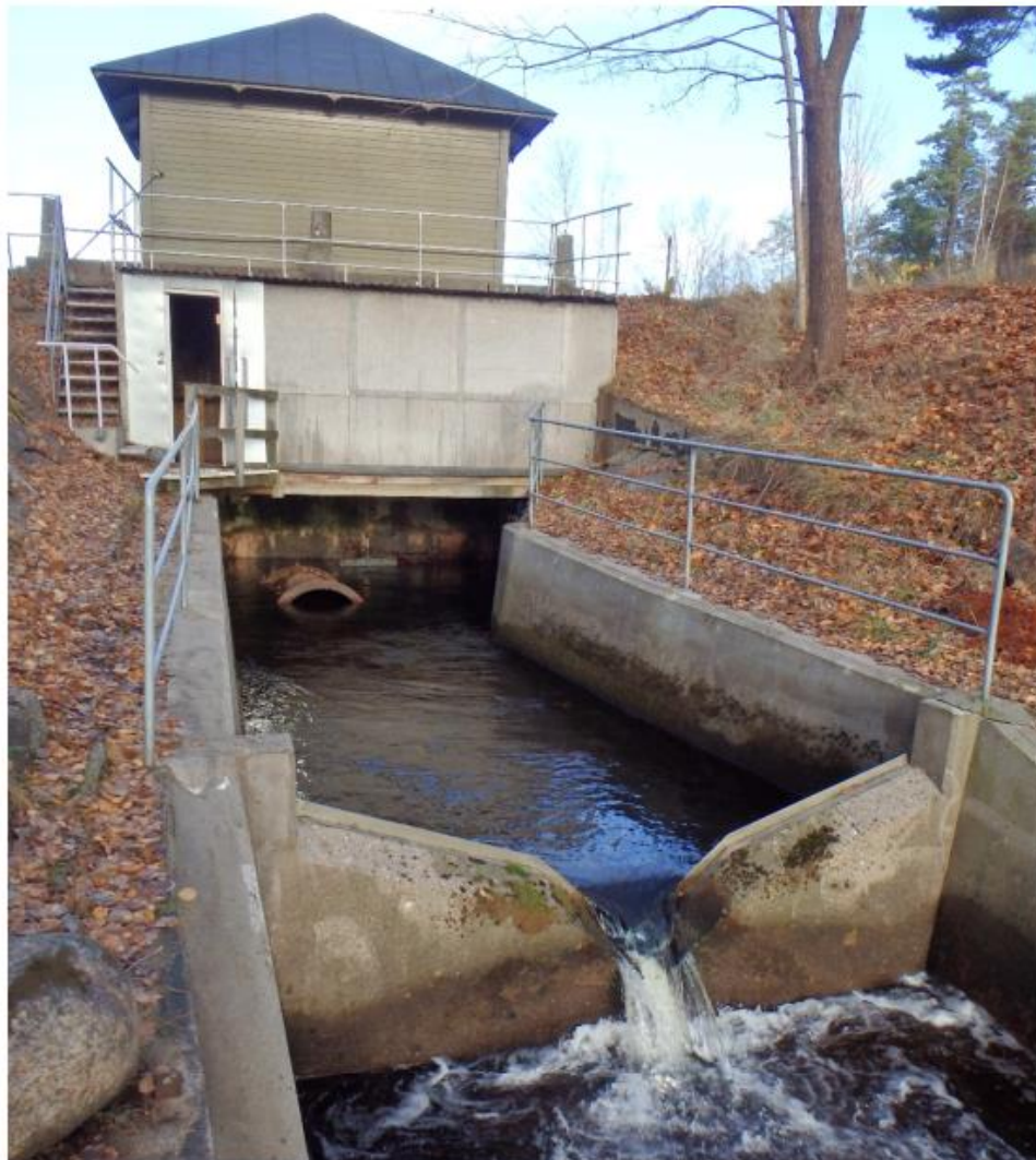
Figur 3. Bild på dammen och Thomsonöverfallet nedströms i flödesriktningen.
