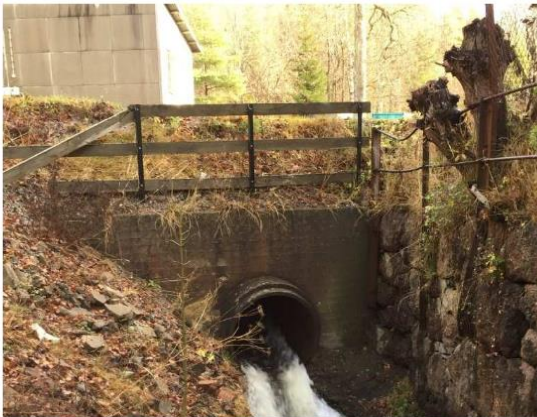
Figur 8. Betongkulvert under vägen uppströms Vigognespinneriet. Foto, SMHI.
