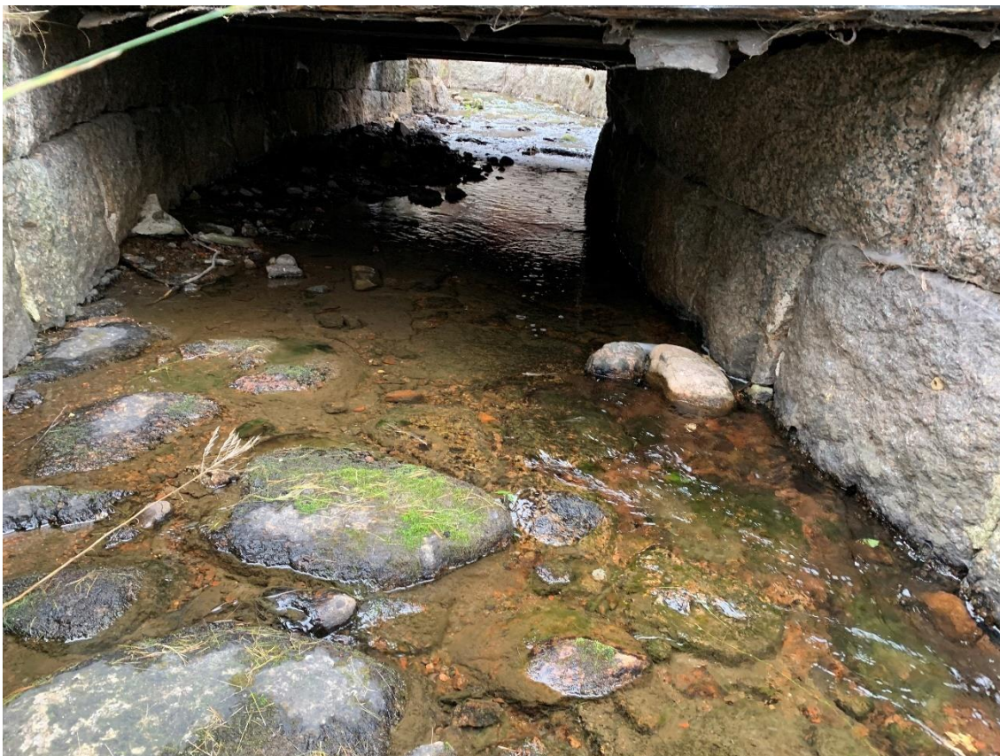
Figur 6. Kanal under garagelänga sett uppströms från (Fiskevårdsteknik, 2019)
