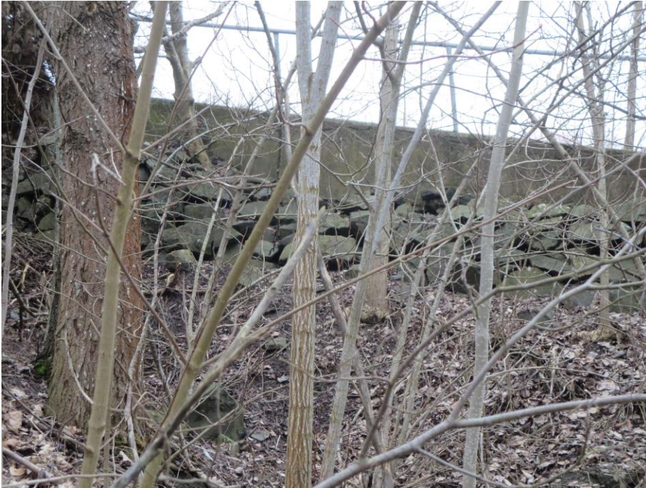
Figur 9. Räcke och betongkonstruktion grundlagd på sprängsten. Foto från platsbesök 2023-02-16.
