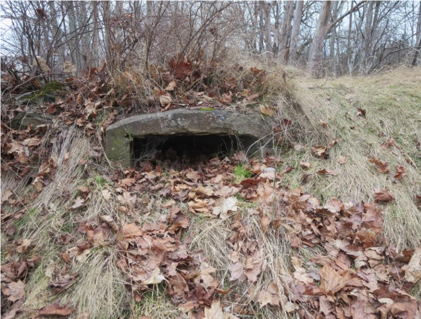
Figur 3. Betongkonstruktioner på Helgeberget. Foto från platsbesök 2023-02-16.
