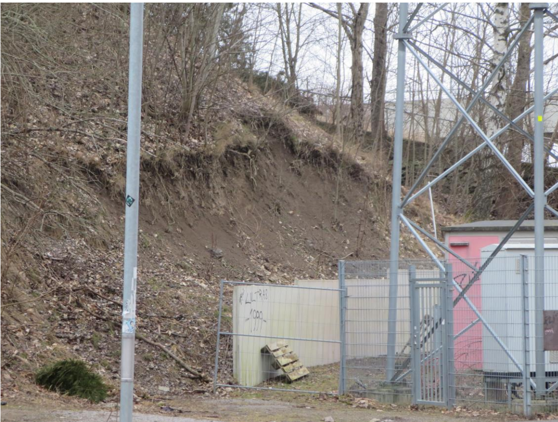
Figur 4. Slänt i nordost. Betongkonstruktion och mastfundament står utanför fastigheten. Om och hur långt in på Såpkullen 1:2 ärret i slänt och vegetation går är inte inmätt. Belysningsmasten är för den intilliggande fotbollsarenan. Foto från platsbesök 2023-02-16.
