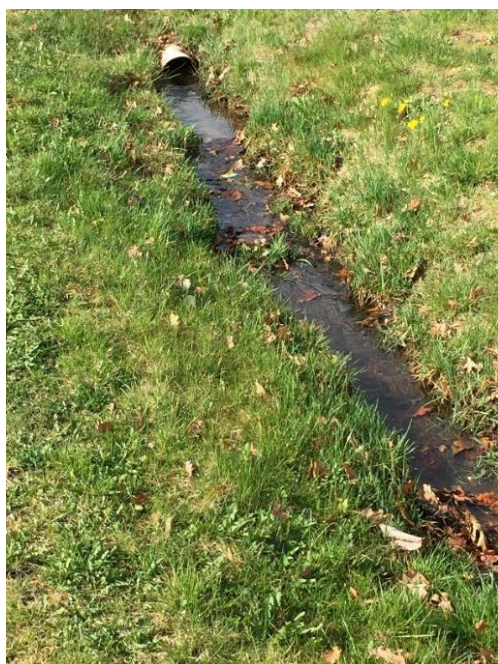
Figur 6 Utlopp vars vatten leds till befintlig ledning lägst med Stockholmsvägen.
