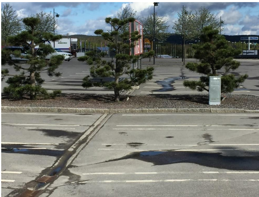
Figur 5 Ränna på parkering som leder ner dagvattnet till stenkista.
