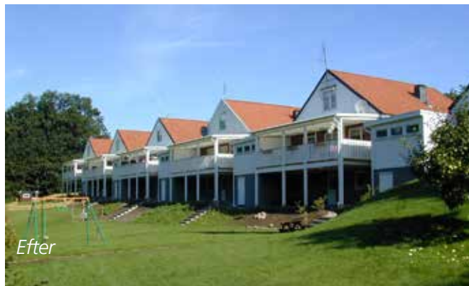
Hus vid Pjältån, cirka år 2000. Förebyggande åtgärd för att undanröja risken för en framtida naturolycka i form av ett skred. Foto: Björn Almgren.
