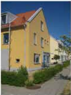
Inspiration; radhus med entréer mot gatan, Linköping
