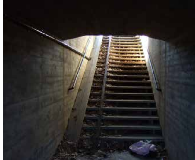
En gångtunnel av denna typ kan upplevas som otäck och bilda en barriär, i synnerhet för rörelsehindrade. Foto: Martin Berlin.
