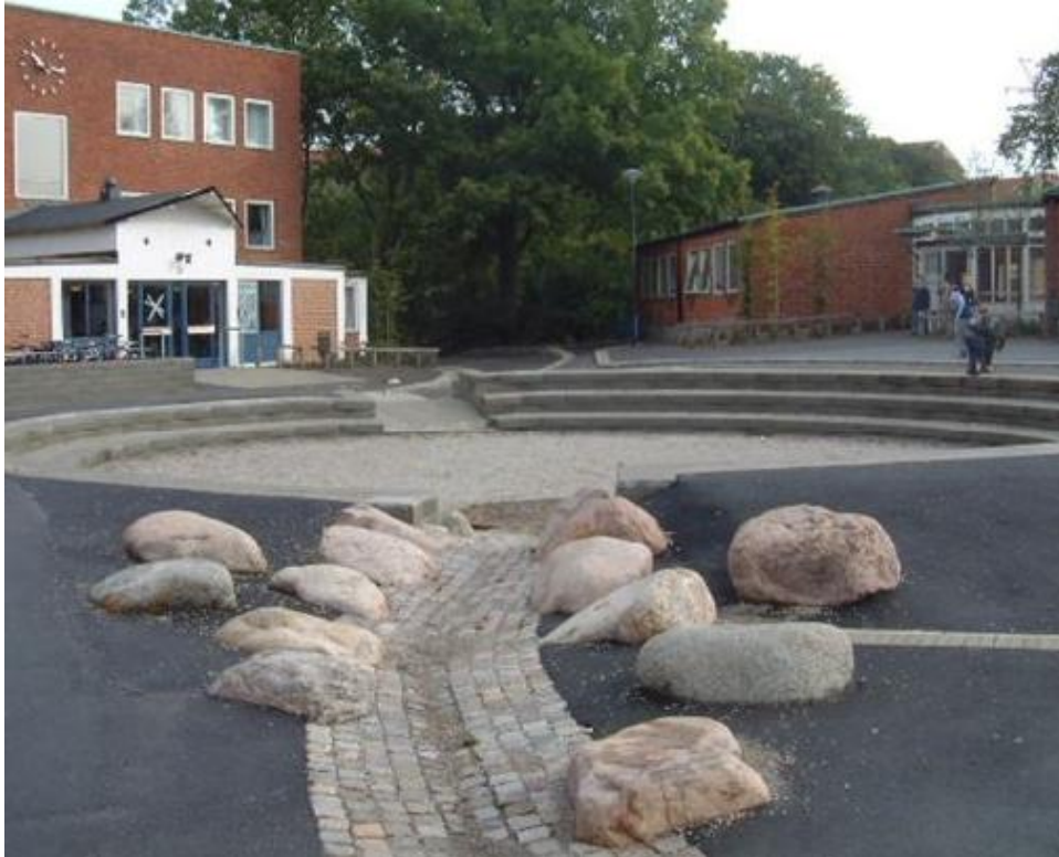
Figur 28 Exempel på kombinerad översilningsyta och fördröjningsmagasinsyta.
