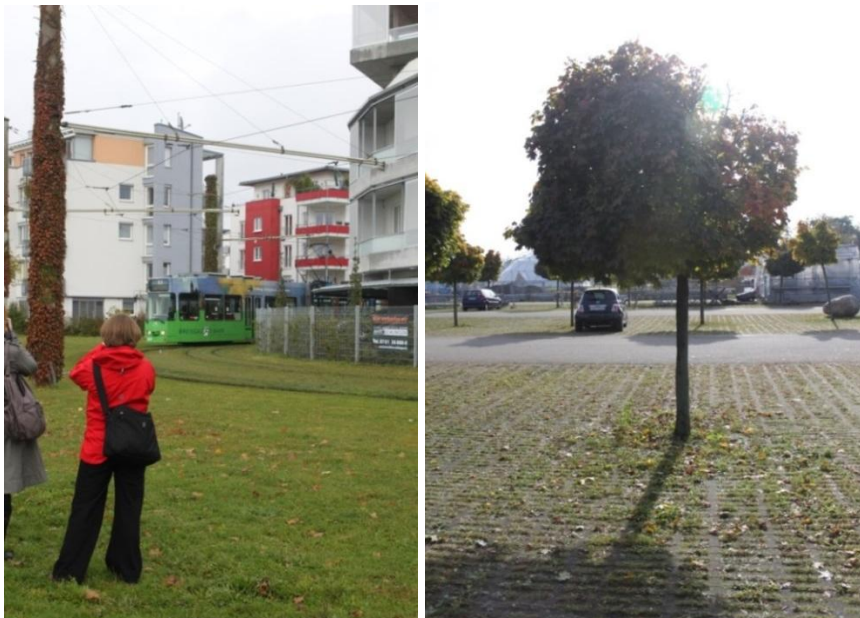
Figur 34 och Figur 35 Grönt spår område respektive genomsläpplig beläggning i parkeringsyta
