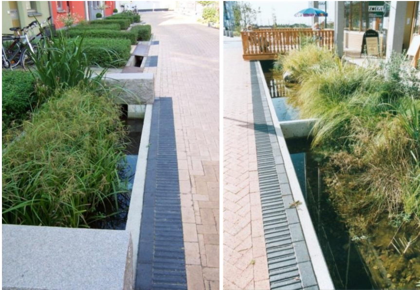
Figur 32 och figur 33 Ytlig dagvattenhantering i form av liten kanal och fördröjningsmagasin som utformats som en rain-garden.
