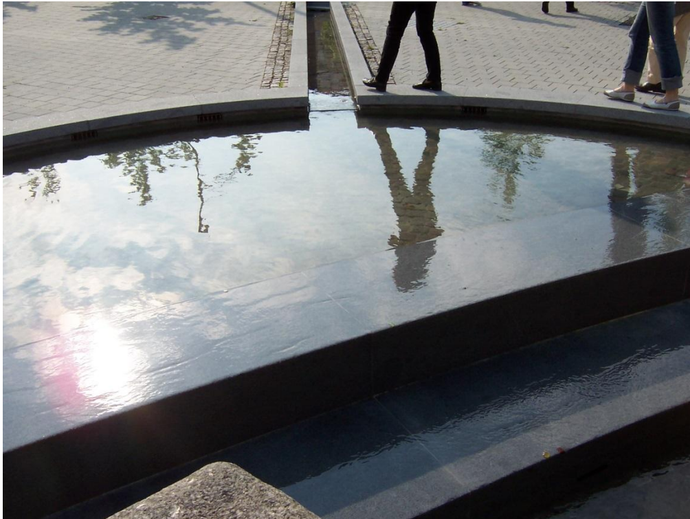
Figur 27 Dagvattenkanal som leder vatten till ytligt fördröjningsmagasin. Lösningen enligt figur 27 behöver vattenpåfyllning vid torrväder för att se ut som på bilden.
