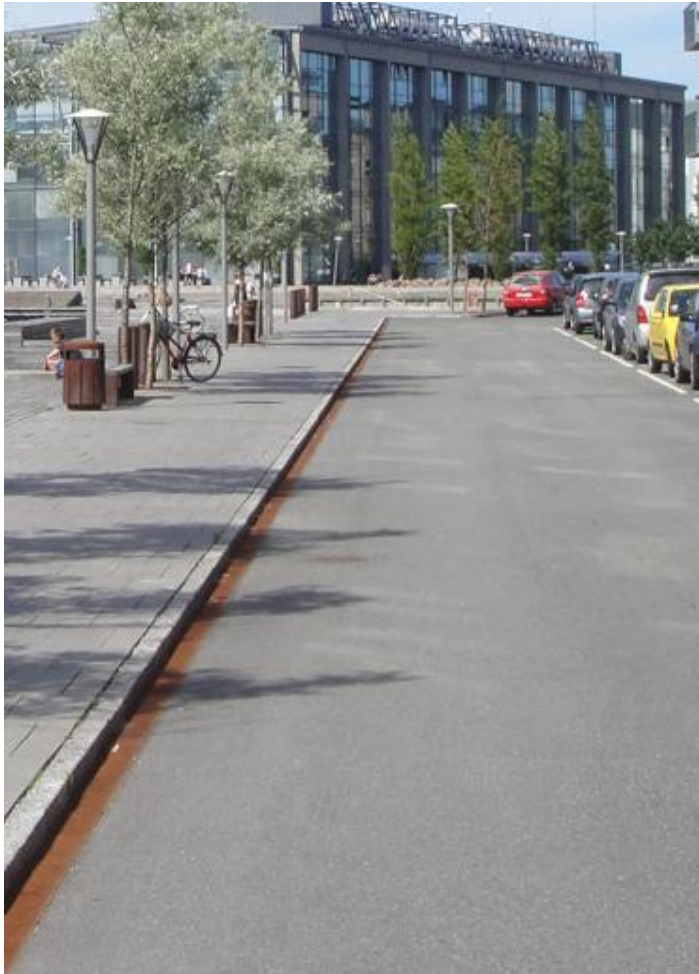
Figur 10 Exempel på gata med linjeavvattning
