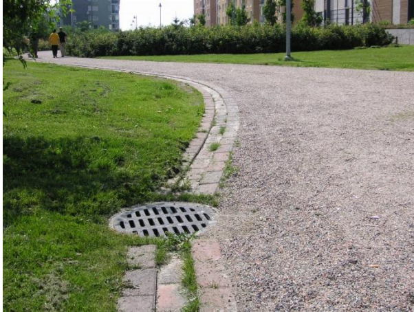
Figur 16 Enkel ränna för avledning av dagvatten
