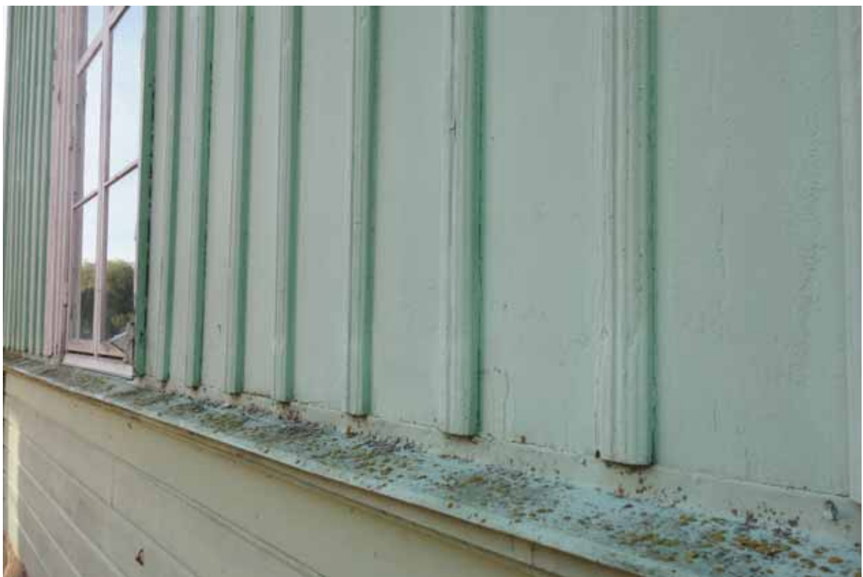
Fasadpanelen är av hög ålder och lockläkten är mycket intrikat utförd med ett spår imitten och profilering på vardera sidan.
