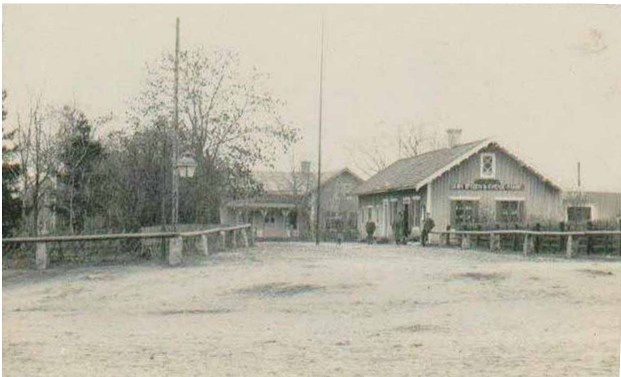
Äldre fotografi av Bossgård 17:1, infarten norrifrån, troligen 1900. I bakgrunden kan man skimra huset som fortsatt står på platsen. I förgrunden syns det som troligen användes som butik. Se även kartan på S.51 för referens. Man kan skönja nyligt planterade träd på tomten framför huset. Notera även att verandan är öppen. Foto från Vikbolandets hembygdsförening.
