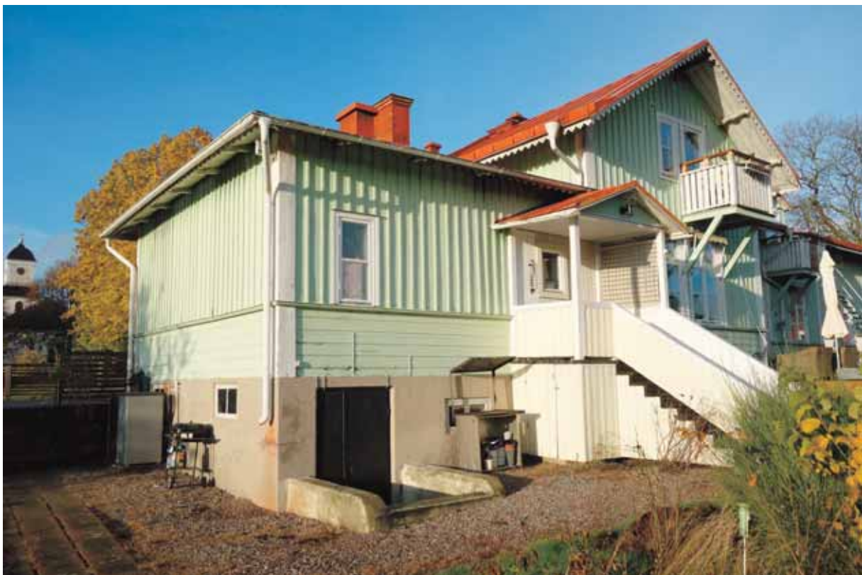
Utbyggnad, troligen från tidigt 1900-tal med putsad grund. Denna del har även ett enklare utförande i panel och locklister.
