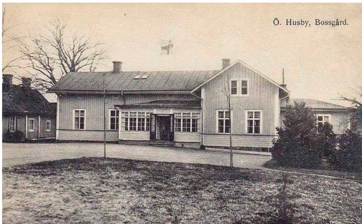
Fotografi av bostadshuset på Bossgård 17:1 från 1920-talet. Verandan är här inbyggd med glasad överdel. Centralt syns det som troligen var gårdens ursprungliga utsträckning som byggts till och fått en t-form samt en utbyggnad mot höger (väst). Foto från Vikbolandets hembygdsförening.
