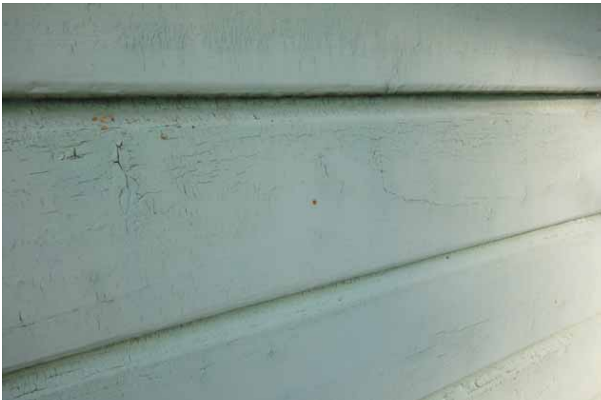
Liggande panel har ett rundat hälkäl i övre kanten och en rundning nedåt.
