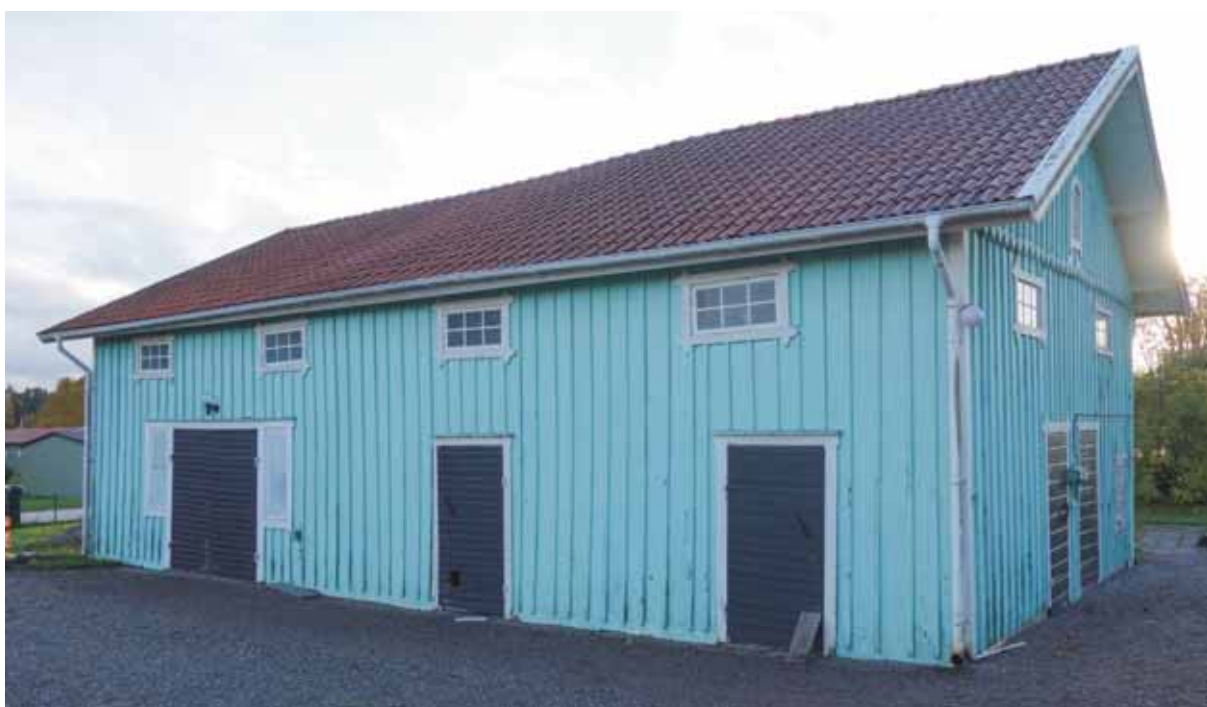
Översikt av huset. Tre entréer mot öst och två mot norr. Byggnaden är täckt med panel och lockläkt. Omfattningar av enkel typ eller med spetsiga avslutningar.
