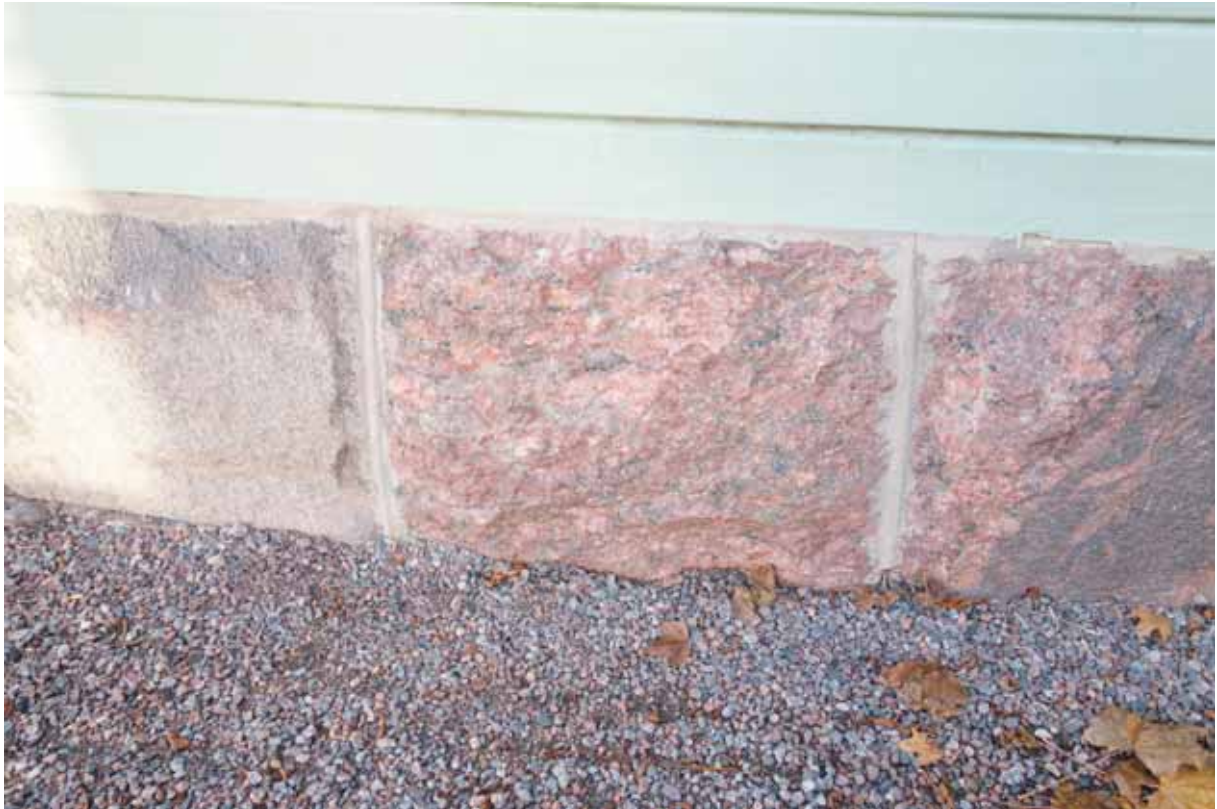
Murad grund av röd sten som huggits till block. Här syns pärlfog mellan stenar.
