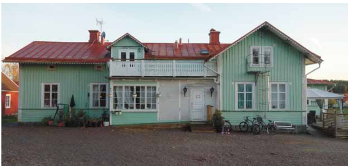
Översikt av bostadshuset på fastigheten. Den vänstra byggnadskroppen är av allt att döma den äldsta delen. Till höger är en utbyggnad som skapar T-formen, troligen från 1800-talets slut. I förgrunden syns den inglasade verandan samt balkongen. Takkupan uppförd under 1900-talets andra hälft.
