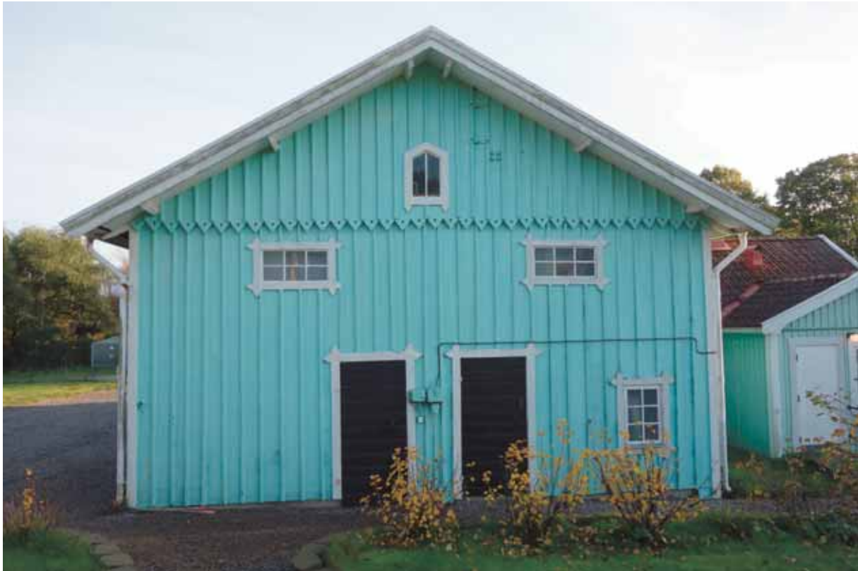
Ekonomibyggnadens gavelsida med utanpåliggande panel i gavelrösten och spetsad, dekorativ panel. Taktassarna är här utbyggda och profilerade likt bostadshuset. Detta förekommer ej på andra sidor av byggnaden. Fönster och dörrar är älderdomliga.
