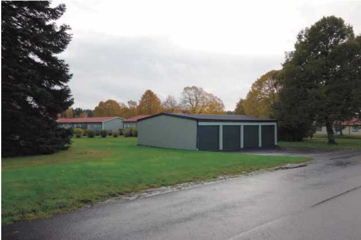
Söder om fastigheten finns öppna gräsytor och parkering som ansluter till den låga bebyggelsen, i bakgrunden till vänster syns låga kedjehus.
