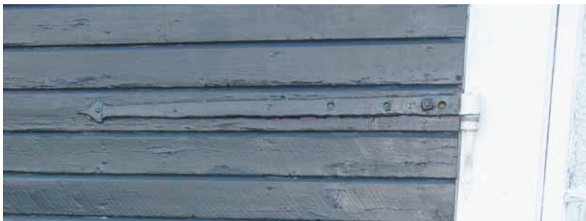
Smitt bandgångjärn med fyrkantsmutter, typen var vanligt förekommande innan 1800-talets mitt.
