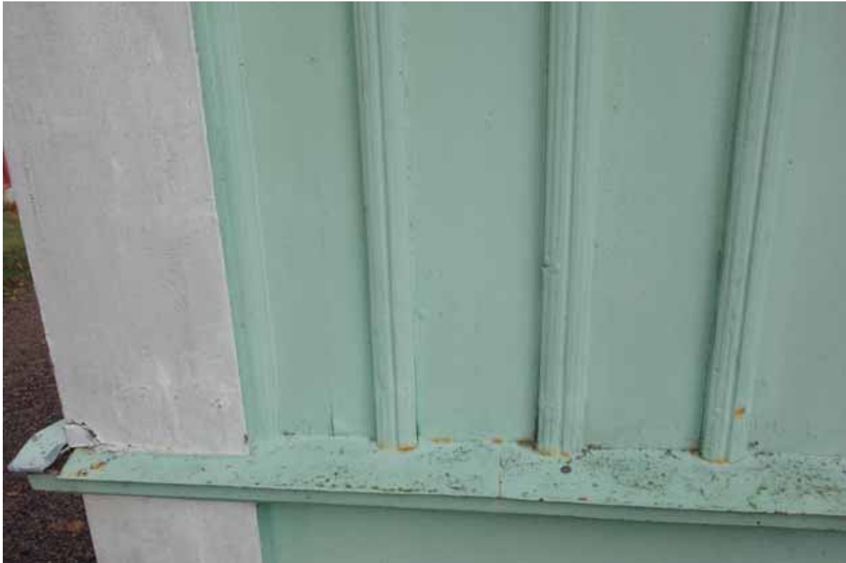
Locklisterna är spikade med smidd- eller ricklippspik som syns tydligt på flera ställen i panelen.
