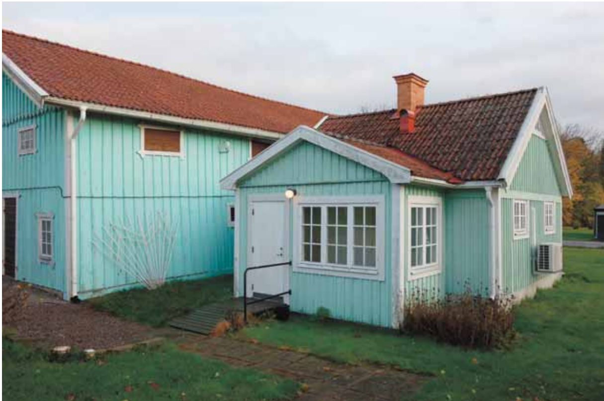
Utuset i anslutning till ekonomibygnaden är troligen från tidigt 1900-tal, men är renoverad och utbyggd. Fönster och panel etc. är av modernt snitt. Även skorstenen ser ut att vara renoverad eller ommurad under mitten av 1900-talet.
