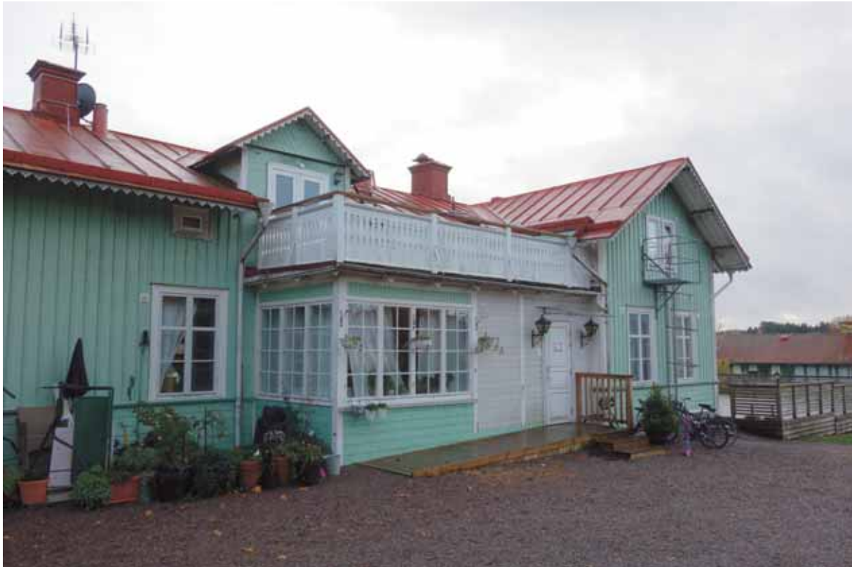
Verandan mot norr som glasats in, samt därefter byggts om under 2000-talet. Ovanpå verandan finns en balkong och en anslutande takkupa med balkongdörr.
