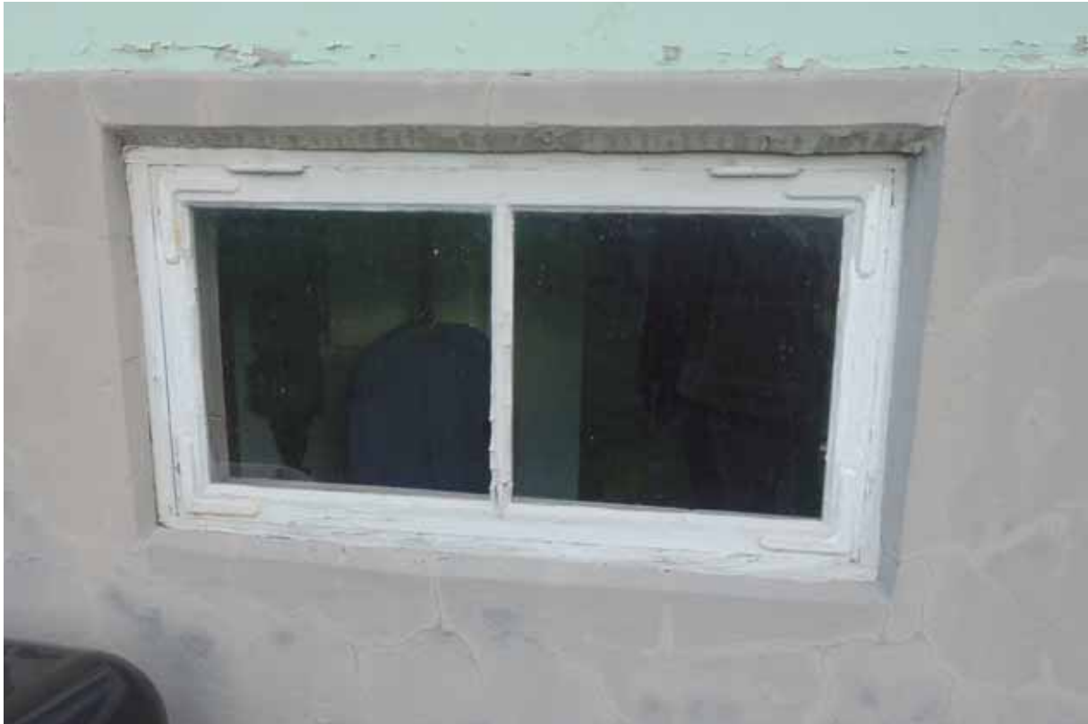
Fönster i utbyggnad mot sydväst. Troligen har denna del använts som pannrum eller dyl. Delen har äldre fönster, troligen från 1900-talets början.
