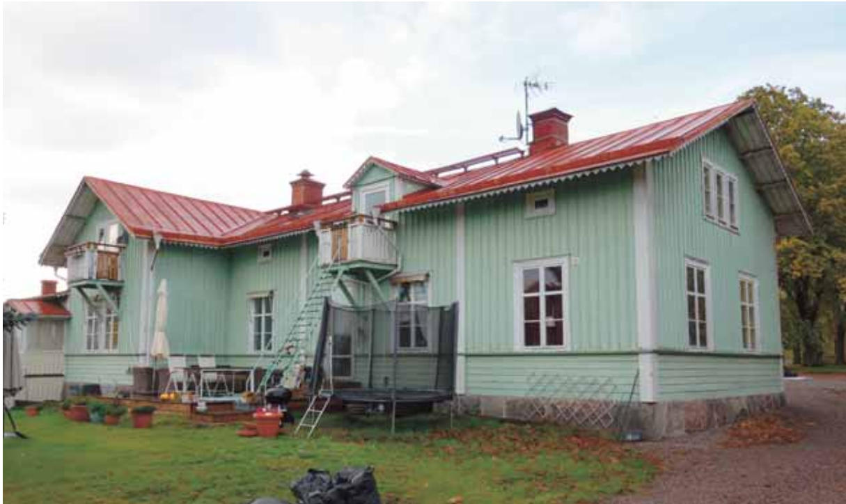
Huset sett från sydöst. Panelutformning med liggande panel under fönster samt avdelande list och därefter stående panel. Vita knutbrädor och fasadavdelande listéner syns även. Huset är placerad på en böj naturstensgrund.
