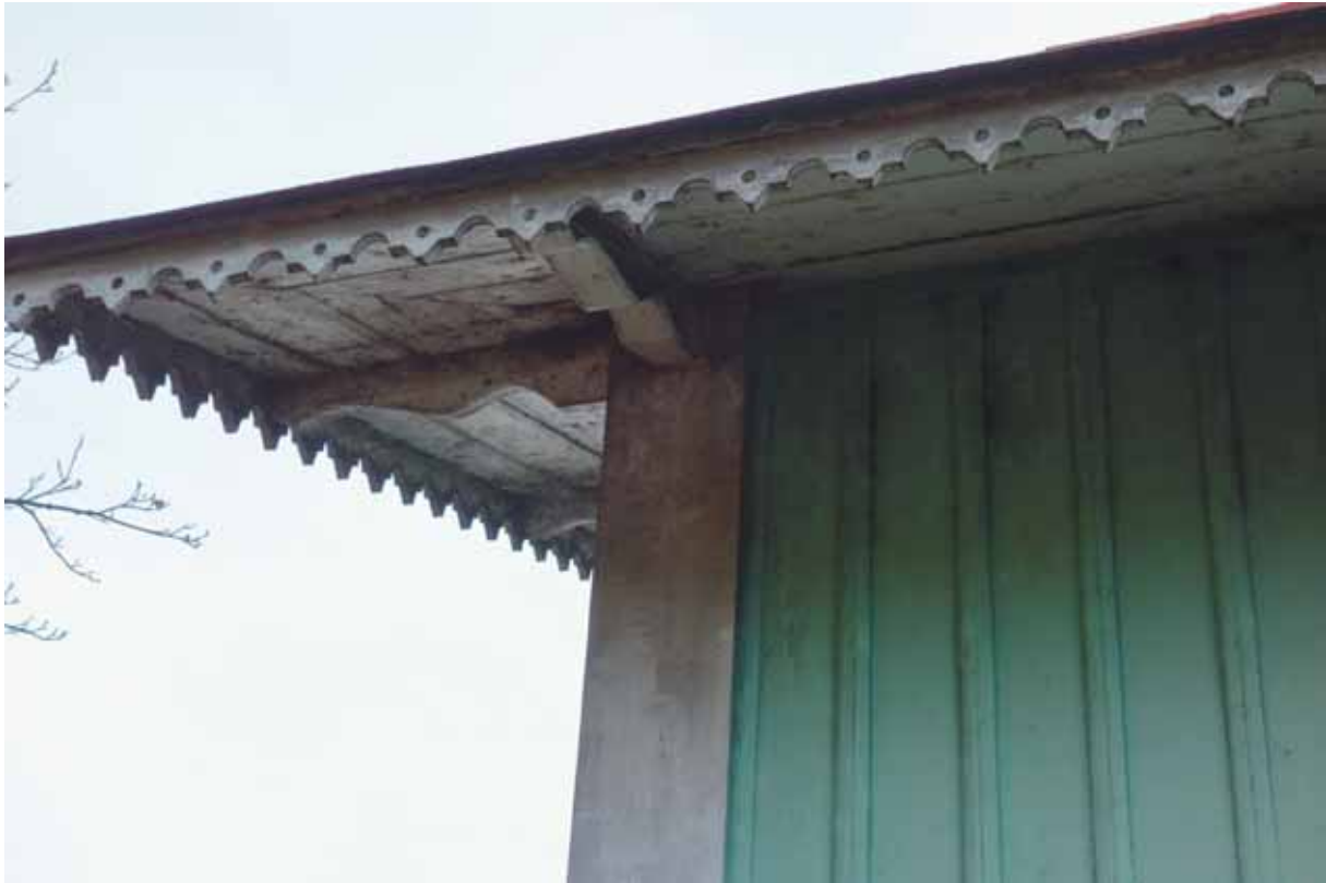
Profilhuggna taktassar och lövsägeri av lambrekäng i takfoten smyckar samtliga delar av byggnaden. Underlagstaket som sticker utanför vägglivet har också profilerade spåntade brädor med en noggrant medveten utformning.
