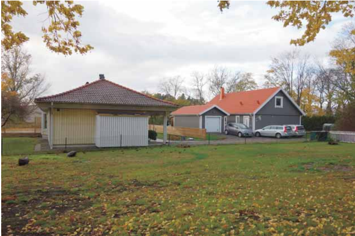
De två villorna nordväst om Bossgård 17:1. En i ett plan och det andra i en-och-ett-halvt plan. Byggnaderna håller låg profil och en-och-en-halvt plans huset saknar takkupor.
