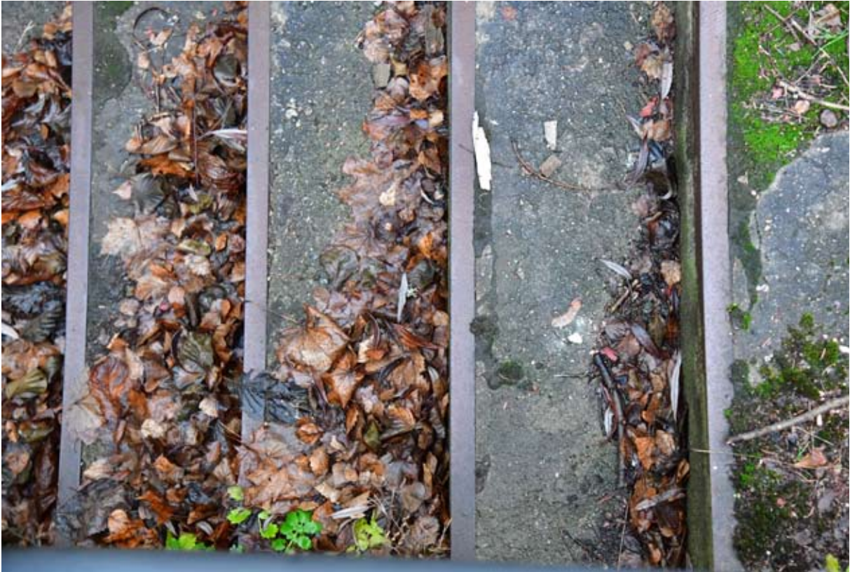
Detalj av betongtrappan vid gaveln mot öst.
