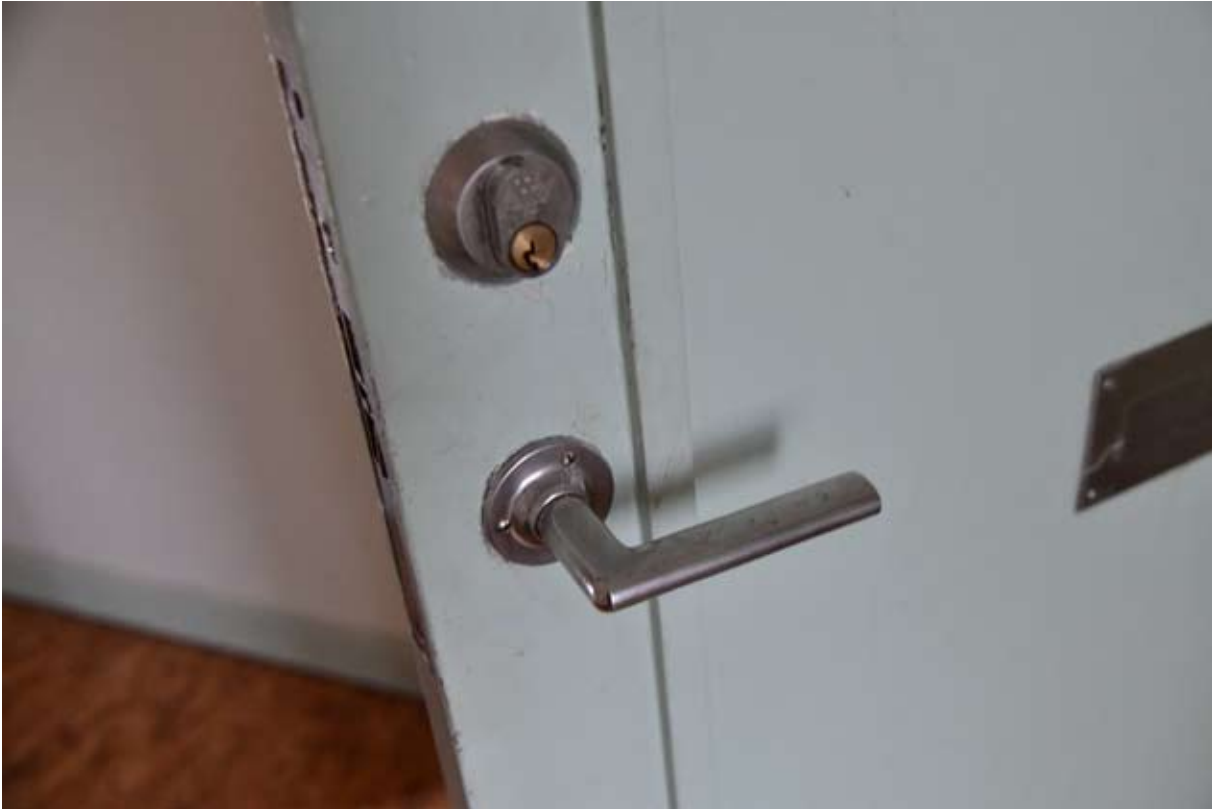
Lägenhetsdörr med äldre funkistrycke. Lås och låskista är dock sentida.
