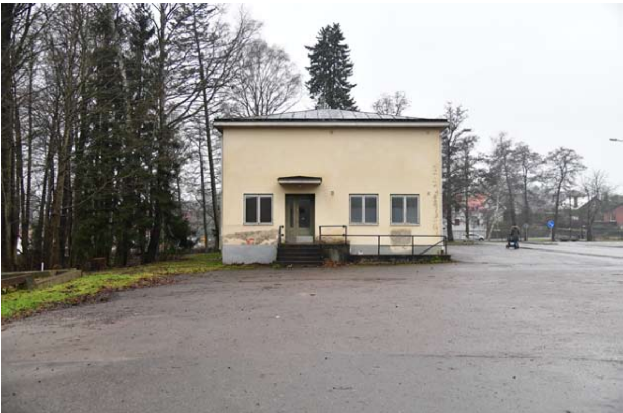
Brandstationens gavel mot öst. Här finns en sidoentré samt källarsvale med typiska funkisräcken i metallrör.
