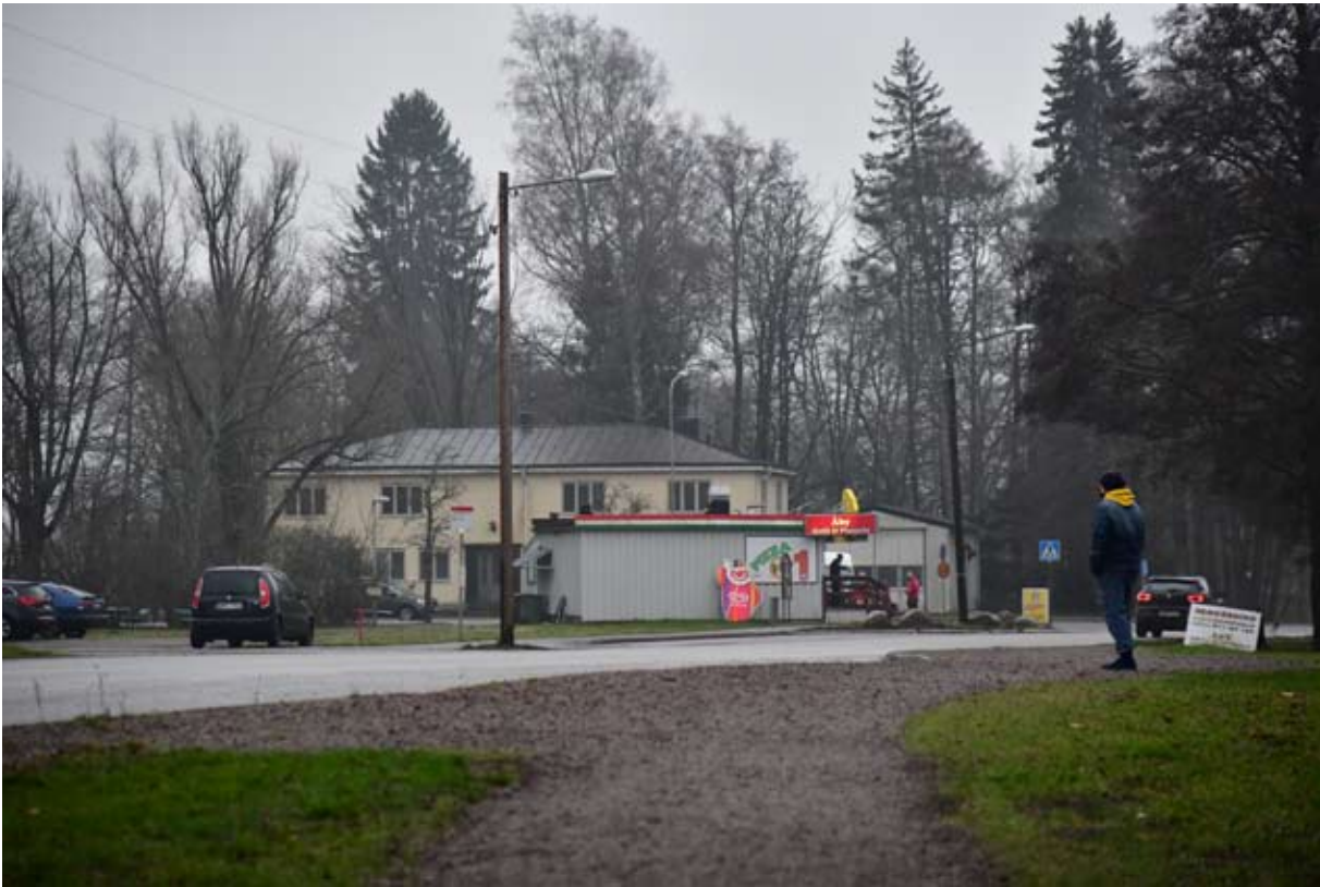
Vy över planområdet södra del från norr, utmed Katrineholmsvägen. Denna vy mot Brandstationen är värd att bevara.
