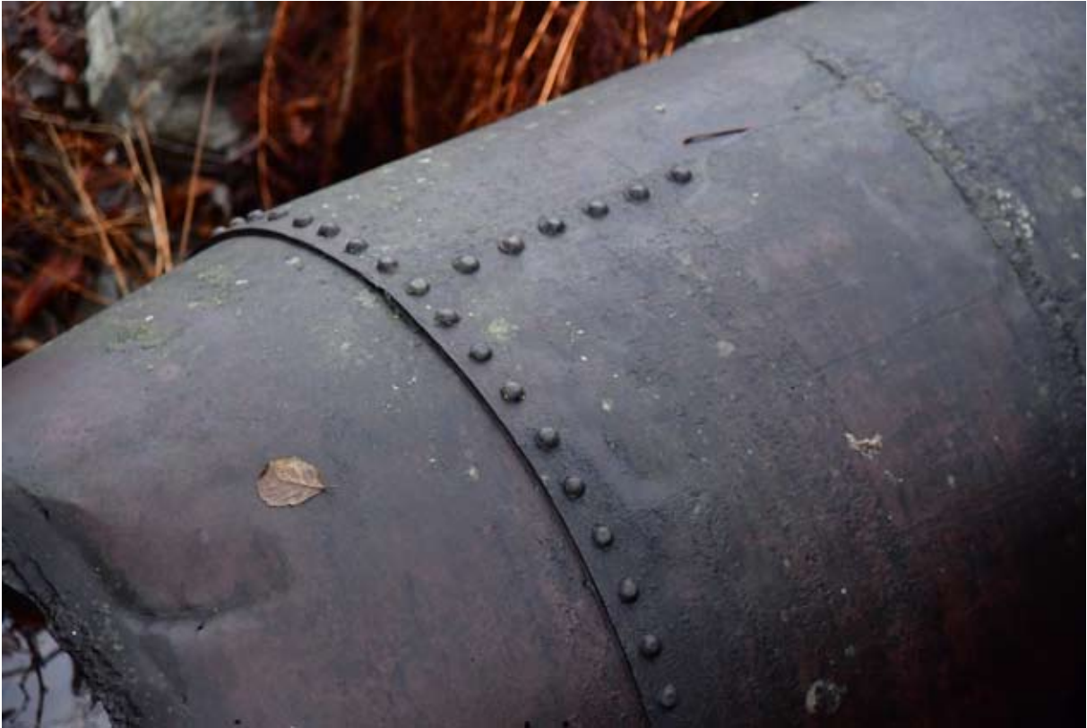
Nitad vattentub av äldre modell vid dämmet vid Torshagskärrs utlopp i Torshagsån. Strax utanför planområdet. Denna typ av rester från tidigare verksamheter berättar om vattendriftens historiska betydelse för platsen.
