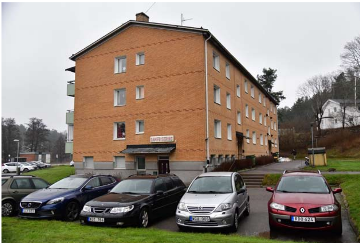
Flerbostadshuset från 1950-talet strax norr om planområdet. Byggnaderna har tilläggsisolerats och balkongbytt under 1980-talet och bevarar ganska lite av sin ursprungliga gestaltning. Skylten på gaveln har flyttats ut i samband med isoleringen. Frisersalongens placering minner om platsens tidigare centrumfunktion.
