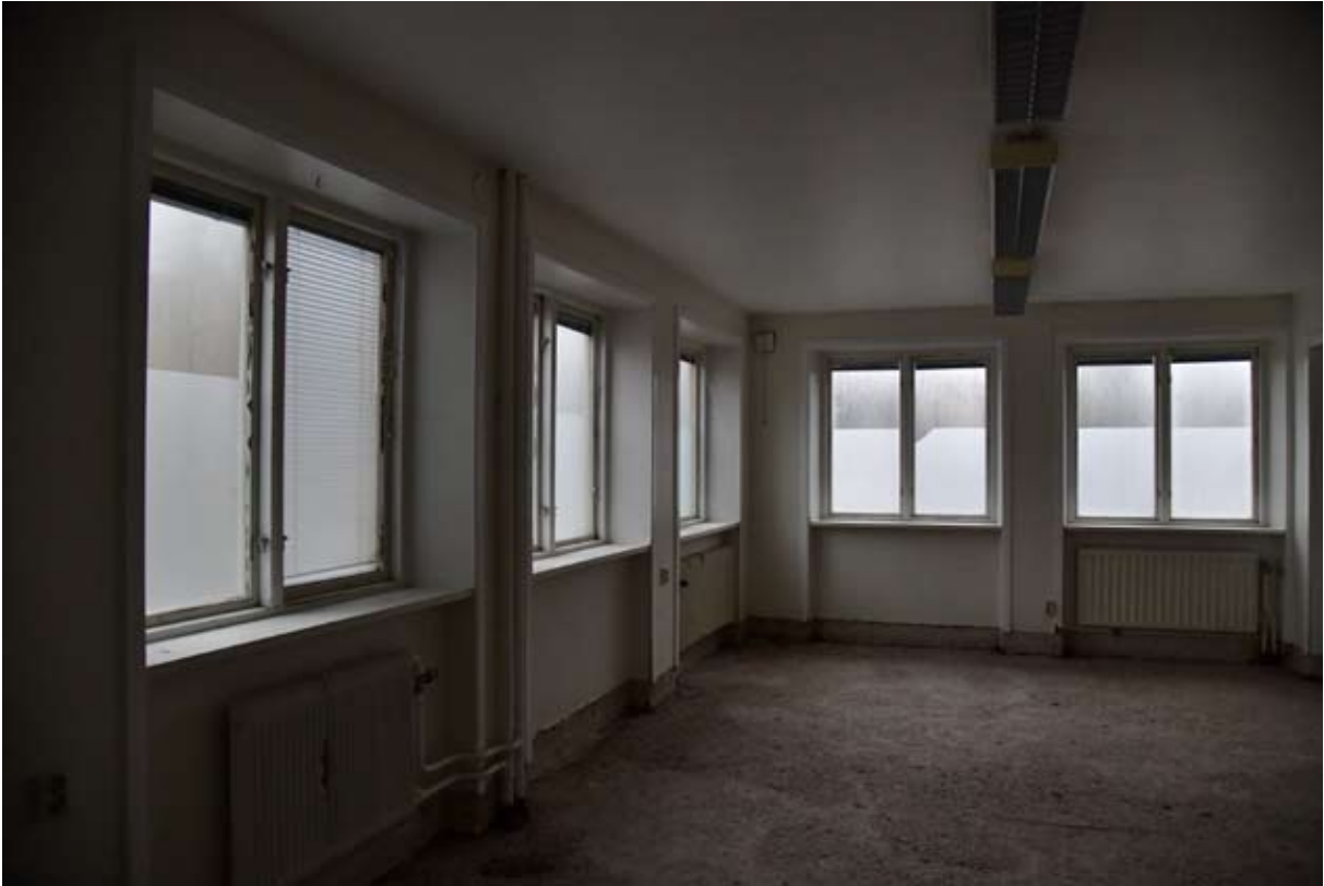
Utrymme på bottenvåningen som haft flera skiftande funktioner under byggnadens historia. Notera den sentida radiatorn till höger i bild.
