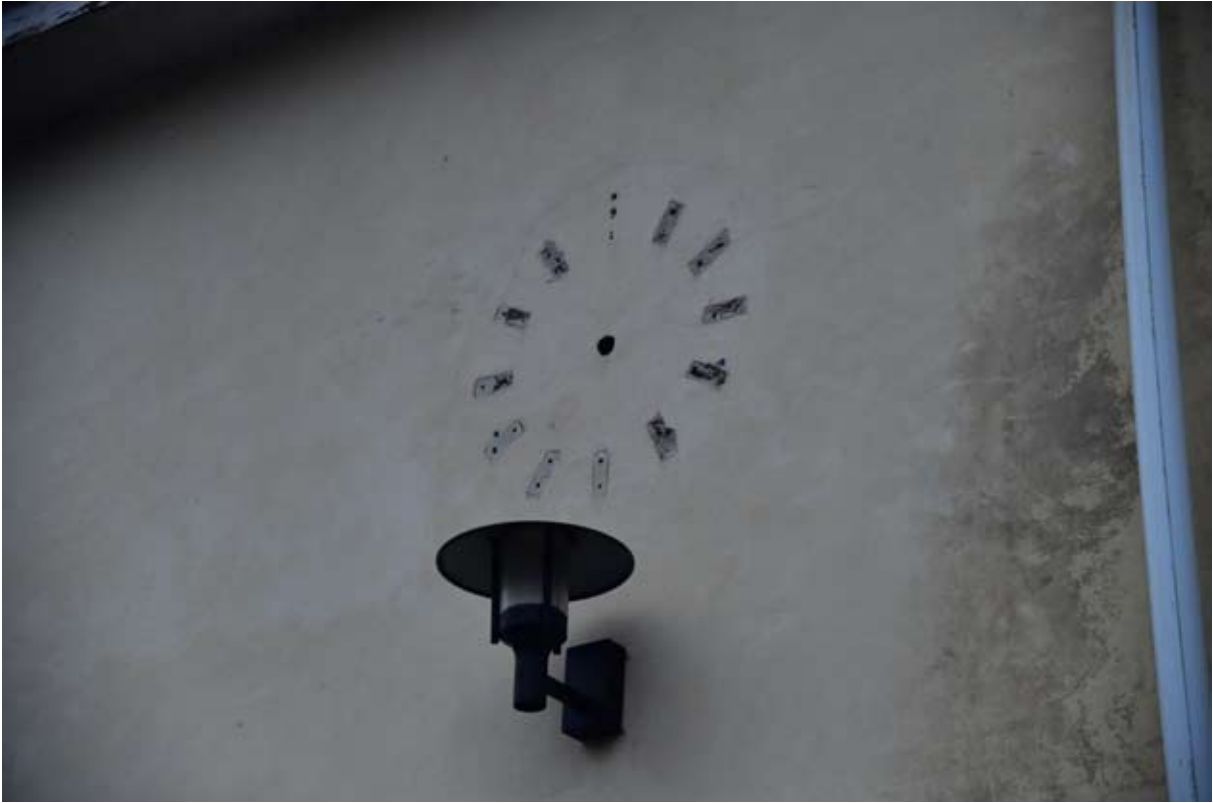
Fasaddetalj med spår av fasaduret. Detta markerade byggnadens status som offentlig byggnad.
