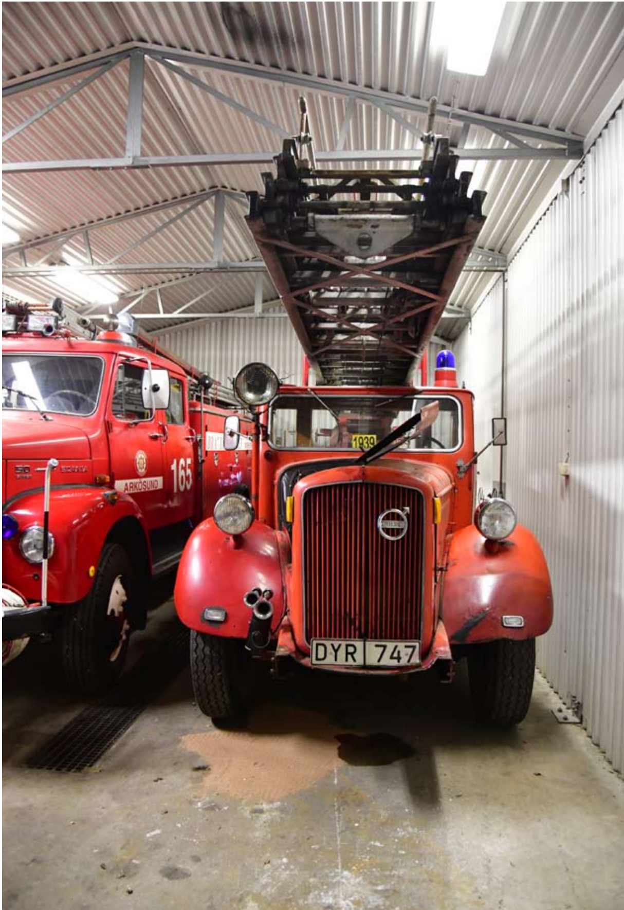
Den tillbyggda plåthallen från 1991 är utförd med stomme i stål och väggar i sandwichkonstruktion. Hallen rymmer lite större fordon än garaget i den äldre delen av byggnaden.
