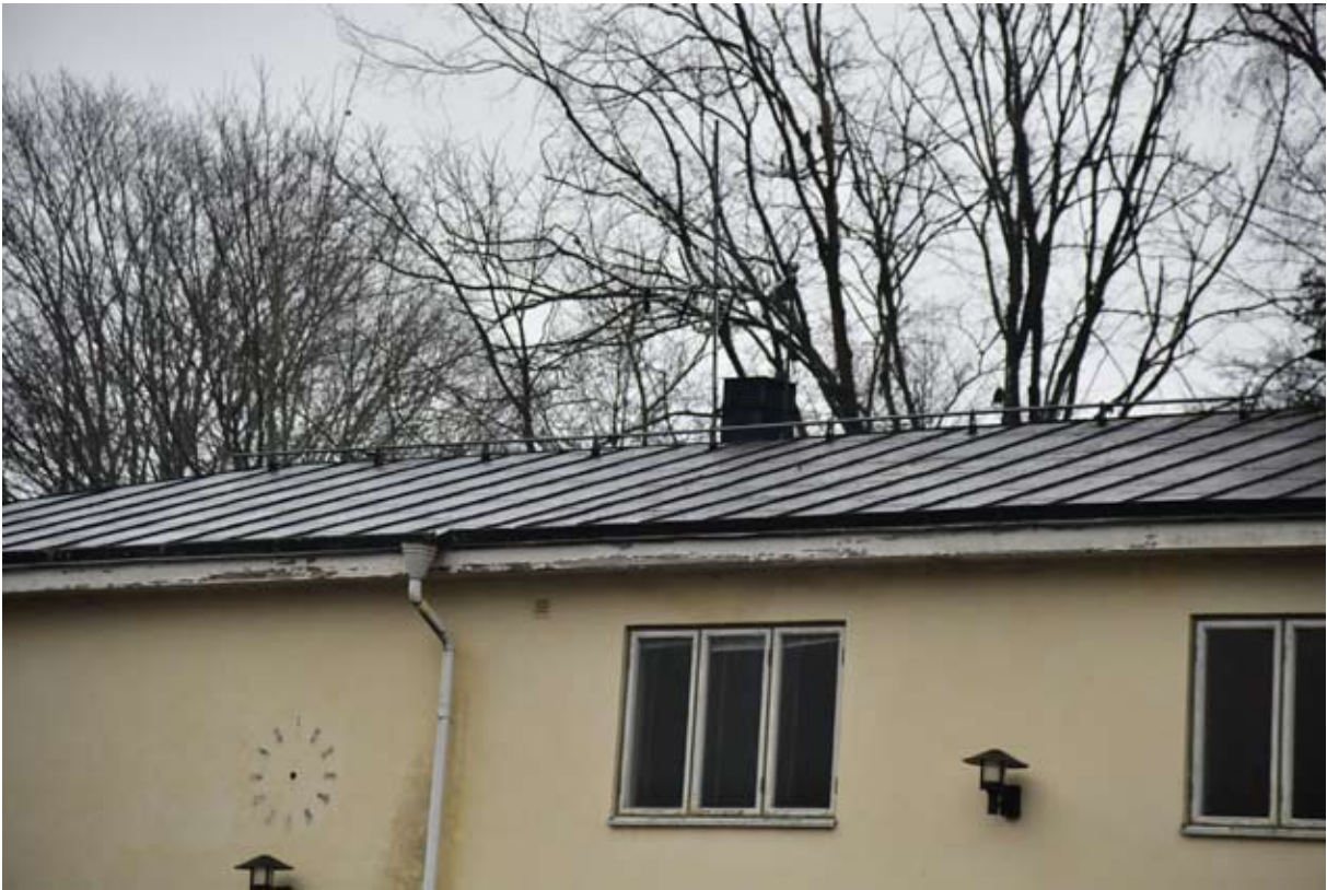
Detalj av byggnaden med dess karakteristiska låglutande valmade tak klätt med plåt i skivtäckning.
