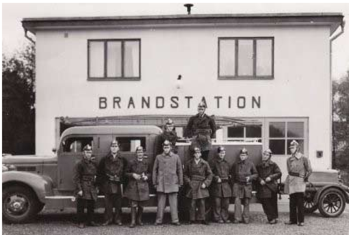
Åby brandkår någon gång mellan 1935 och 1942. Man har här fått upp den karakteristiska skylten i funkisstil. Foto från Brandhistoriska sällskapet
