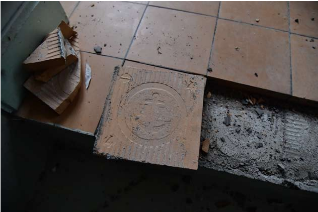
Klinkergolv, detalj med firmastämpel.
