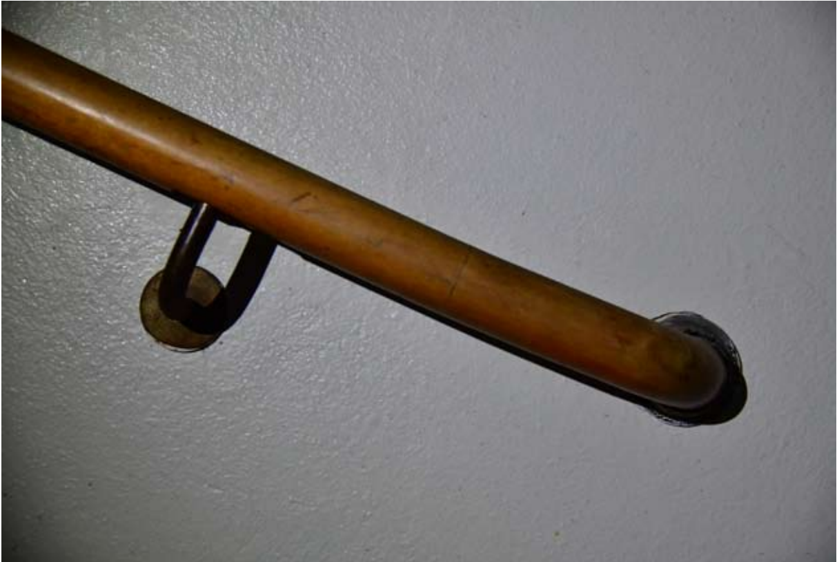
Detalj av handledare med ändbeslag och upphängning. Ursprunglig detalj.
