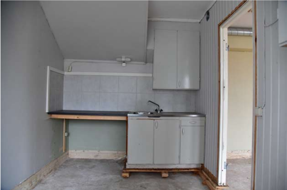
Delvis bevarat pentry på bottenvåningen med äldre skåpsinredning och diskbänk. Ytskikt och handtag sentida. Även innerväggen till höger är sekundär. Äldre färgsättning i grönt anas bakom den rivna inredningen till vänster. Notera den klassiska funkisarmaturen under trappan.
