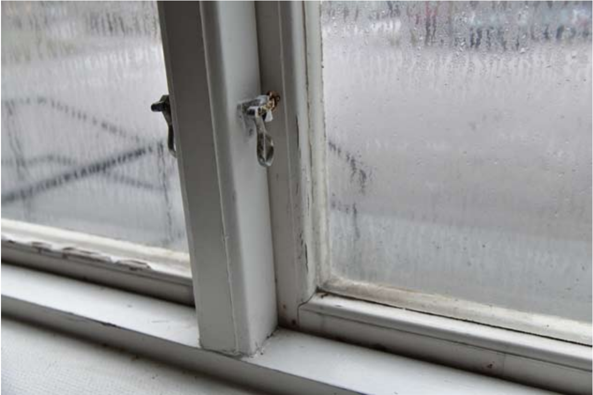
Detalj av originalfönster från 1944 i bottenvåningen. Kopplade utåtgående bågar. Bågarna är profilerade enligt funktionalistisk standard.
