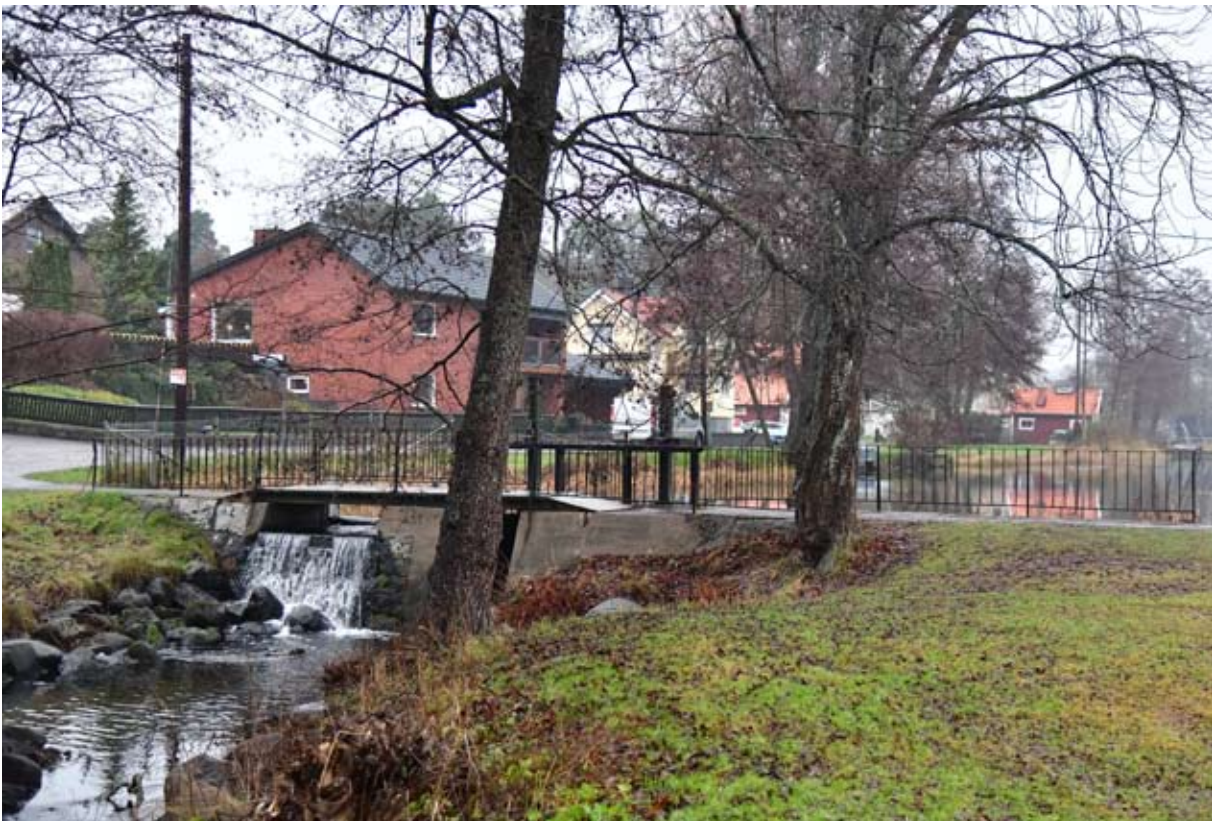
Ett dämme där vattenmagasinet i Torshagskärrs har sitt utlopp i ån. Till höger ans ett tubrör.
