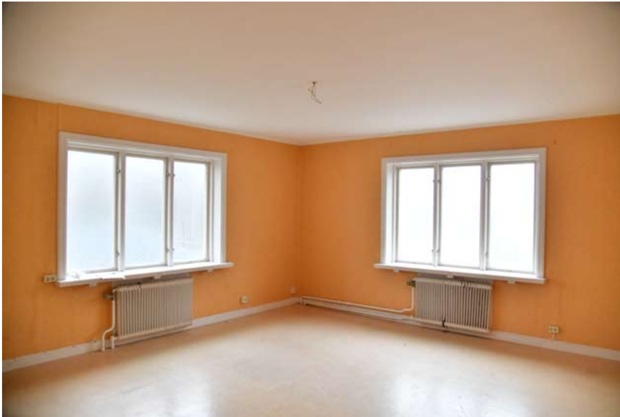
Hörnrum mot nordväst på övervåningen. Originalfönster och äldre sektionsradiatorer. Ytskikt ca 1990.
