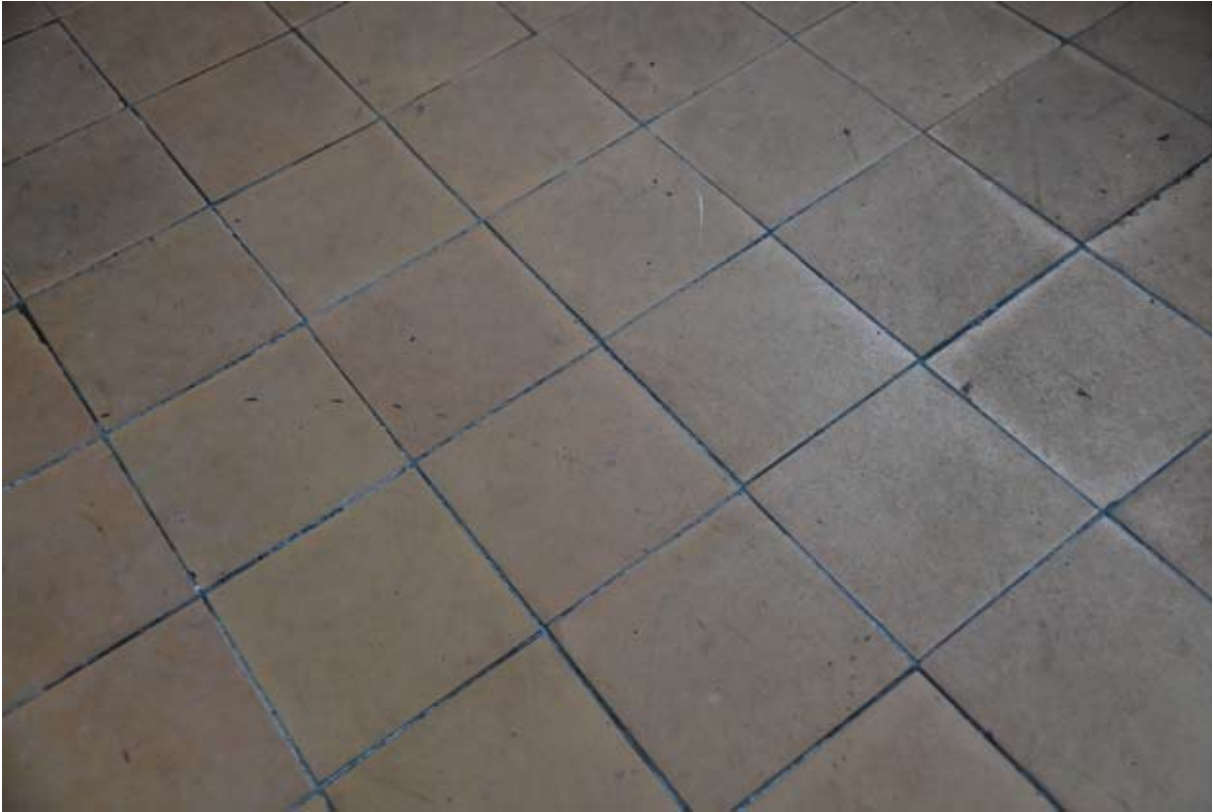
Klinkergolv av industrityp i bottenvåningen, klinkret är tillverkat av Höganäs fabriker.
