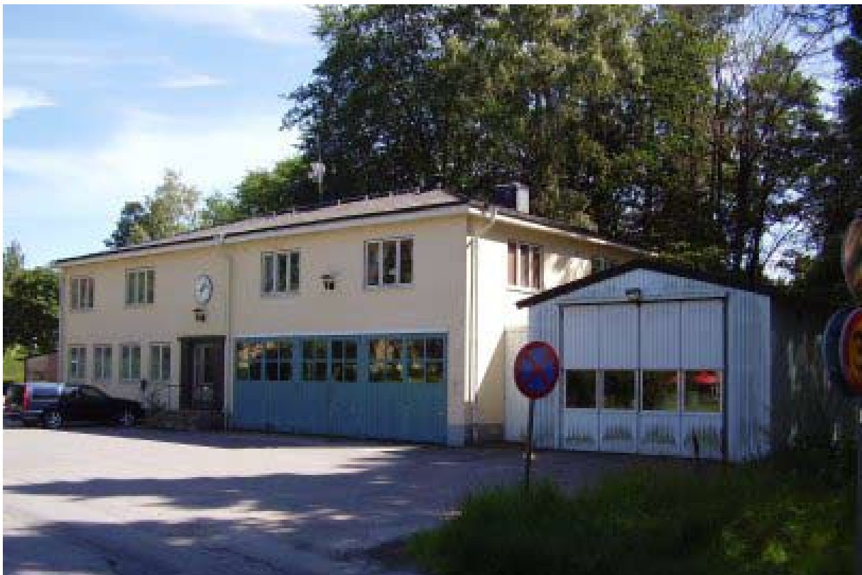
Brandstationen efter nedläggningen 2009 men före 2020. Den karakteristiska skylten över garaget är demonterad, och fasaduret har ersatts med ett väggur. Foto från Brandhistoriska sällskapet
