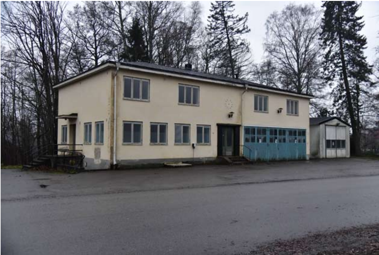
Brandstationsbyggnaden har ett valmat svart plåttak i skivtäckning, en ljus putsad fasad och en grå sockel i betong och puts. Den högra halvan med garaget i bottenvåningen är den ursprungliga volymen. Den vänstra halvan byggdes till under 1940-talet.
