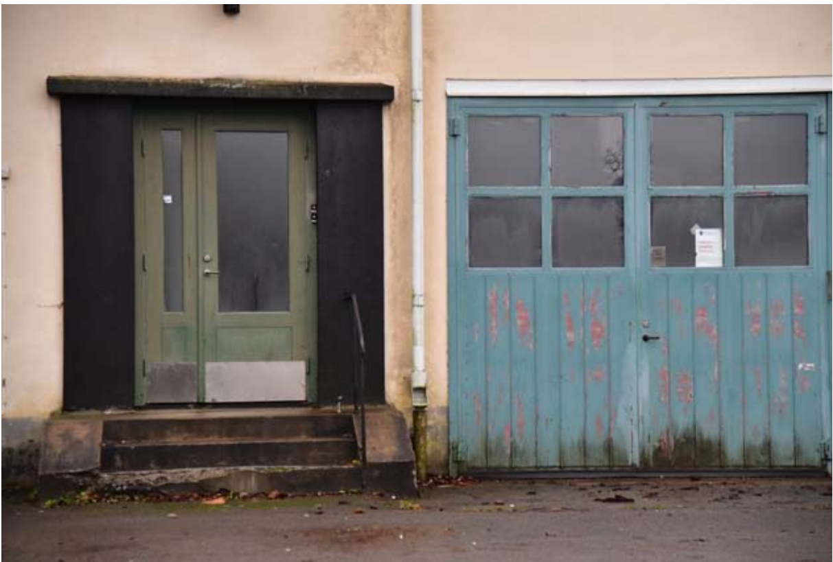
Brandstationsbyggnadens entré och en av garageportarna. Entrédörren är sekundär, men den är lik den ursprungliga. Notera den pampiga trappan med breda vangstycken. Även garageportarna är sekundära i plåt, men ansluter även de till de ursprungliga som troligen var trä.
