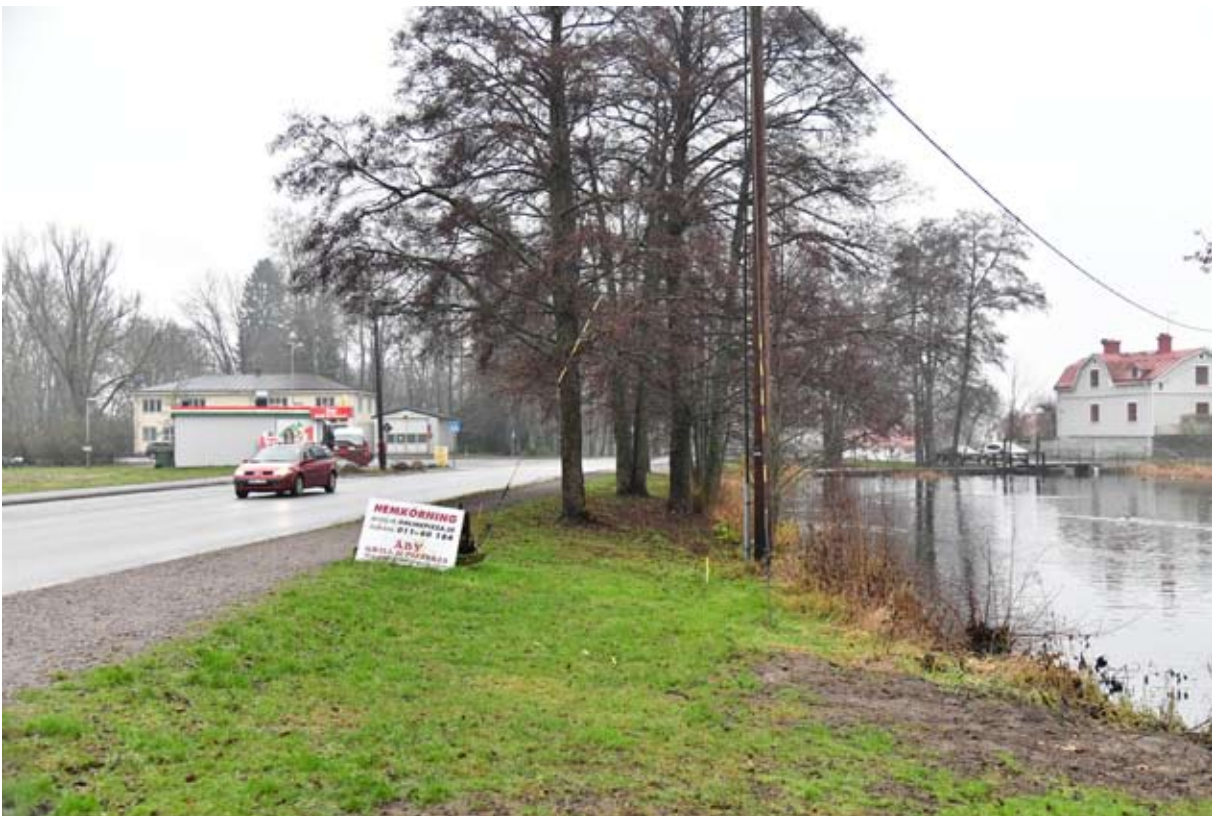
Vy längs Torshagskärret och Katrineholmsvägen. Planområdet till vänster i bild, det övre dämnet till höger och kiosken vid den gamla landsvägen. Bakom kiosken ligger brandstationen.
