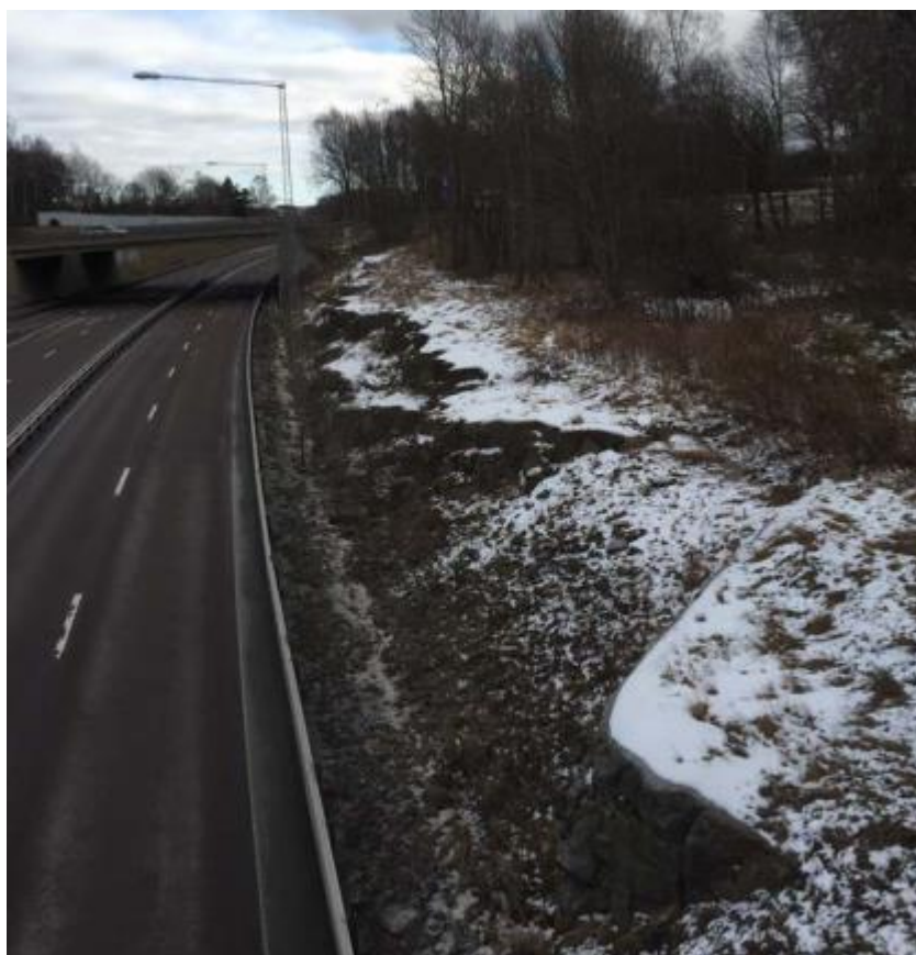
Figur 4. Påvisar den höjdskillnad som finns mellan körbana och planområdet som ligger till höger på bilden. Bilden är hämtad ur PM Riskbedömning upprättad 2016-03-31 [2].
