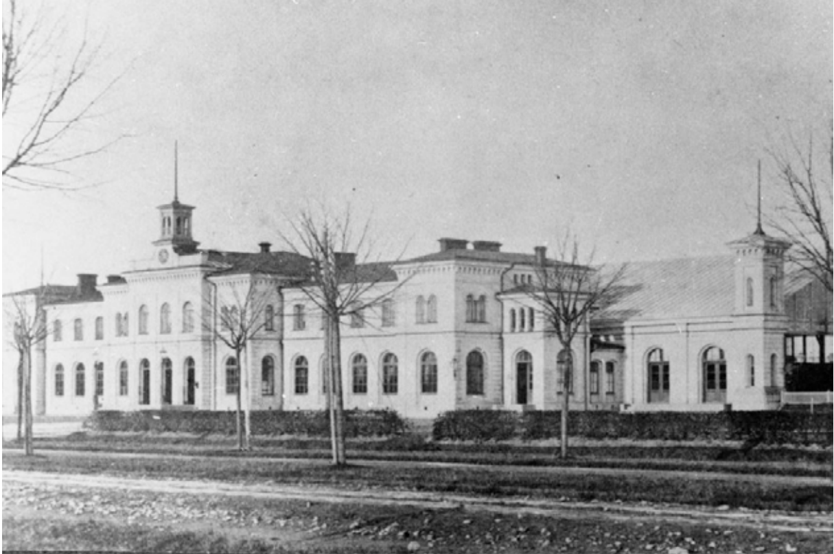
Järnvägen och Norra promenaden har en gemensam historia och är på många sätt varandras förutsättningar. Ett borttagande av spåren och en flytt av stationen med ny bebyggelse som omgärdar det gamla stationshuset kan bidra till kumulativa effekter som påverkar kulturmiljön.
