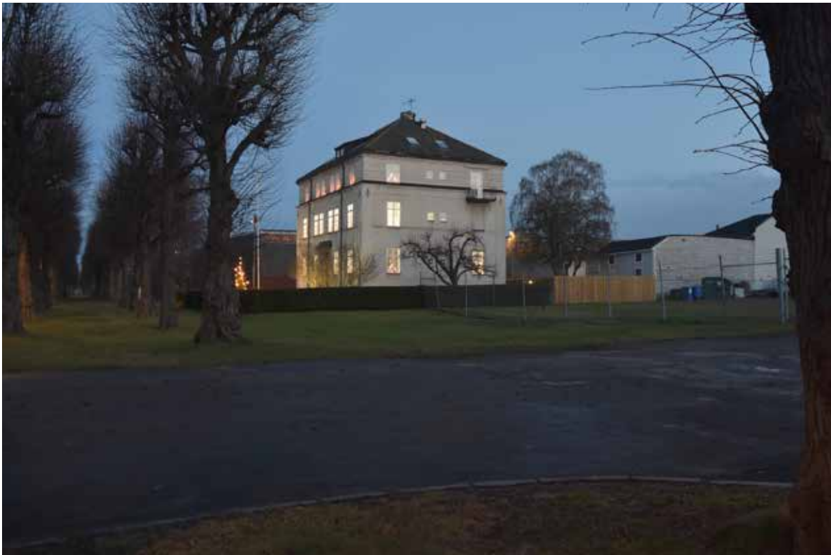
Fastigheten Svanen 6 som tillsammans med sitt gårdsbus är en värdefull historisk komponent i miljön kring Norra Promenaden. Byggnadens läge visar också förhållandet mellan byggnader och förgårdsmark. Något som är viktigt att behålla när ny bebyggelse planeras.
