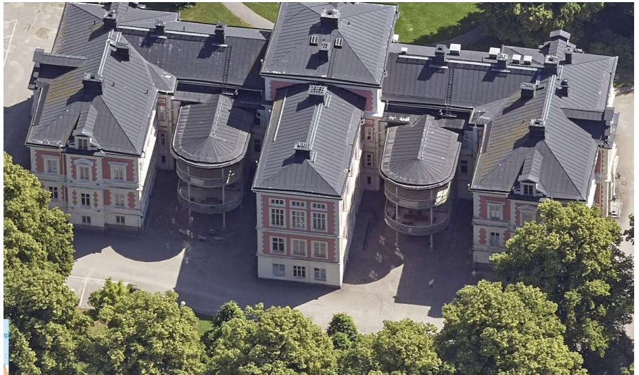
Figur 2. Flygvy över Lennings sjukhems västra del. Nybyggnation som tillkom 2002 är byggd med pelare så denna del påverkas inte av vattnet i samma utsträckning. Foto: Norrköpings kommun.
