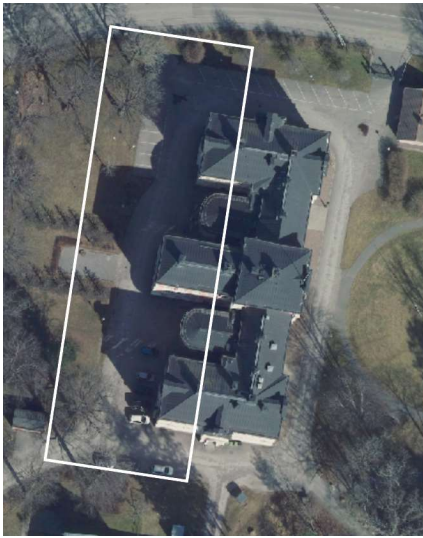
Figur 1. Flygbild över Lennings sjukhem med problemområdet inringat med vitt streck. Foto: Norrköpings kommun.
