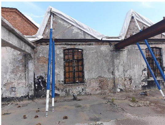
Bild 2. Sågtandsformad tegelfasad vid övergång till tak
