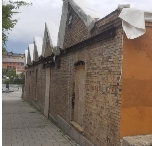
Bild 5. Västra fasaden, utskjutande fasad
