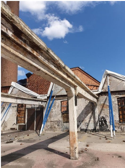
Bild 3. Primärbalkar av betong samt del av golvkonstruktion
