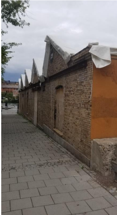
Bild 4. Västra fasaden, hammarband i ök
