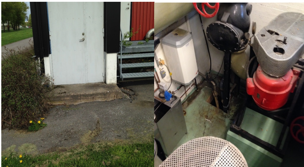
Figur 5. Översvämningsrisk vid dörren (vänstra bilden) som leder ner till returslampumpkammaren, vatten kan pumpas ut med läns pump placerad i botten av kammaren (högra bilden).
