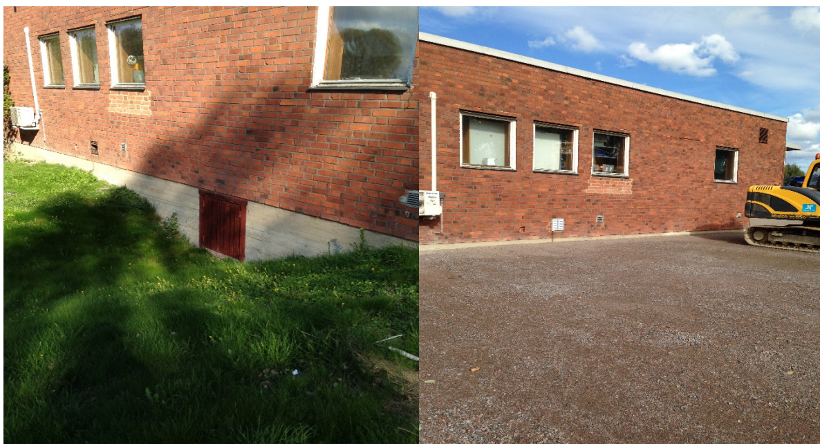
Figur 3. Baksidan av elverkstaden före och efter åtgärd för skydd mot översvämning vid ett 100-års regn.
