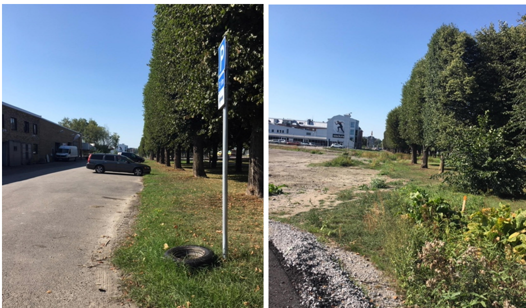
Figur 15. Ytor längs Norra Promenaden där parallellgatan ska anläggas.
