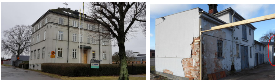
Figur 10. Kontorshus från 1919 med högsta kulturhistoriska värde och tillhörande stallbyggnad och vagnsbod, dessa kommer att bevaras. Den rödmarkerade tillbyggnaden omfattas inte av rivningsförbud med anledning av dess dåliga skick.
