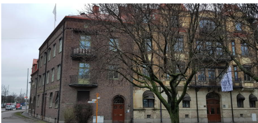
Figur 11. Bostadshus och kontor vid Packhusgatan från 1903 och 1922.
