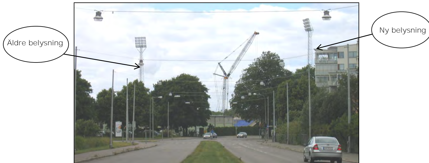
Figur 20. Foto från Albrektsvägen vid byggnation av arenan med äldre (till vänster) och ny mast för belysning (till höger) kring Idrottsparken.
