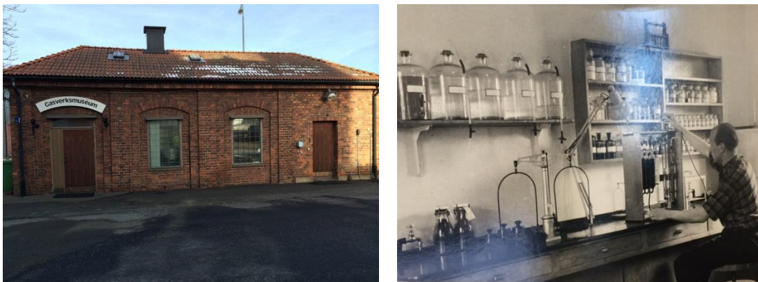
Figur 2 Byggnad 5 - laboratorium, gasmästarkontor och museum. Vänster bild; dagens utseende, höger bild; laboratoriet i byggnaden i drift 1945 (bild hämtad från utställning i aktuell byggnad).
