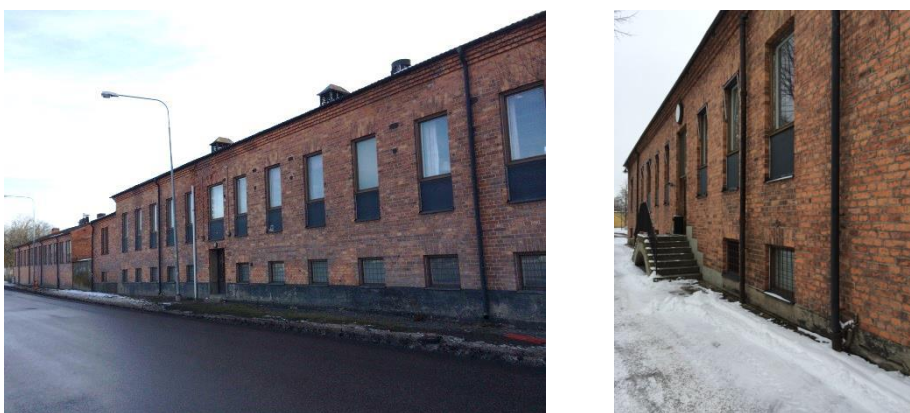
Figur 4. Byggnad 7 apparthus, gaskompressorstation, kontor och personallokaler. Vänster bild; fasad från Saltängsvägen. Höger bild; fasad från innergården.
