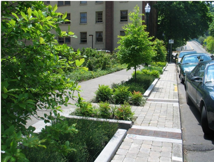
Figur 11. Exempel på nedsänkt växtbädd. Vatten leds i det här fallet in i växtbädden via genomsläppliga plattor samt en öppning i betongmuren. (United States Environmental Protection Agency, 2013).
