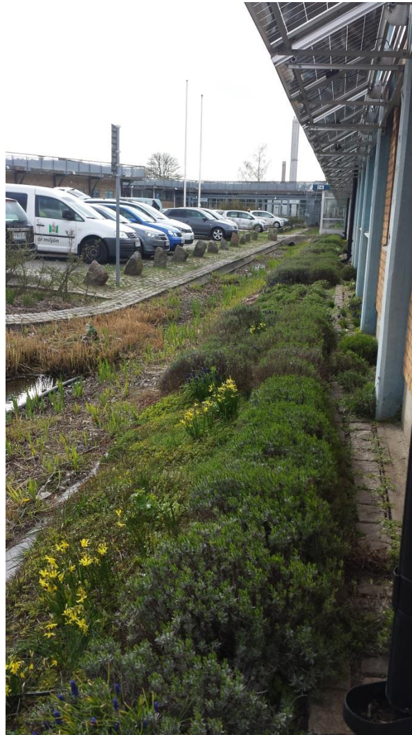
Figur 9. Exempel på sturrör som leder takvatten mot växtbädd.
