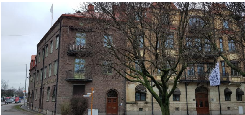
Figur 7. Bostadshus och kontor vid Packhusgatan från 1903 och 1922.
