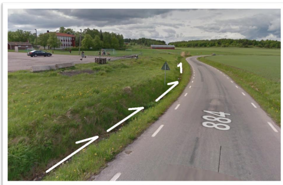
FIGUR 7 OCH 8. DIKEN SOM STRÄCKER SIG LÄNGST PLANOMRÅDETS SÖDRA OCH VÄSTRA SIDA OCH DÄR FLÖDESDIRIKTIONEN ÄR MARKERAD MED PILAR.
