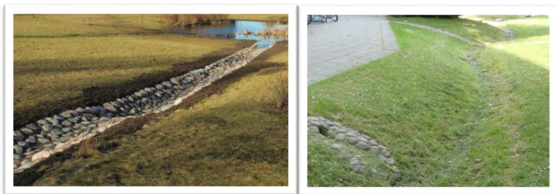
FIGUR 17 OCH 18: AVLEDNINGSTRÅK. TILL VÄNSTER ETT AVLEDNINGSTRÅK MED KULLERSTENAR OCH TILL HÖGER ETT GRÄSBEKLÄTT AVVATTNINGSTRÅK.
