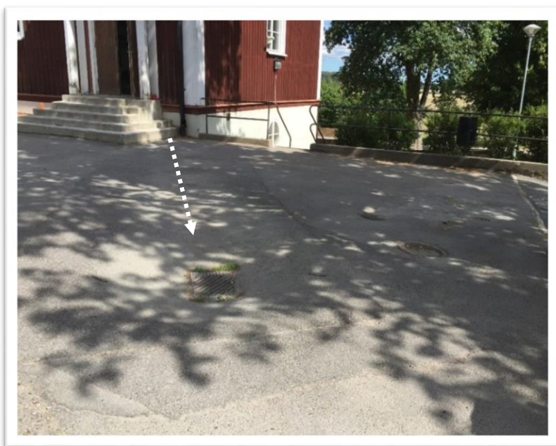
FIGUR 11. EN RÄNNA TILL DAGVATTENBRUNN. PILEN MARKERAR NEDSÄNKNINGEN OCH DESS RIKTNING.
