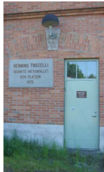
Entréen till pumpverksmuseum.
