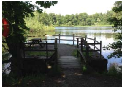
10. Befintlig bygga, upprustning?
