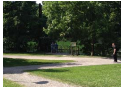
7. Befintlig bygga, upprustning?
