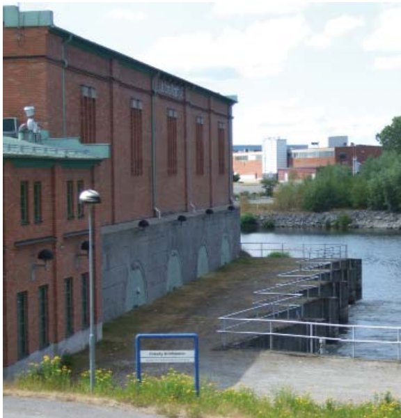
Ljusfors krafts byggnad med tillhörande terrass.
