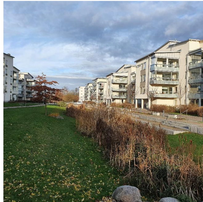
Figur 24. Till v: Principsektion över ett brett avvattningsstråk. (Bildkälla Svenskt vatten P105). Till h: Öppet dagvattenstråk integrerat i bostadsområde, Linköping. (Foto Tyréns AB)
