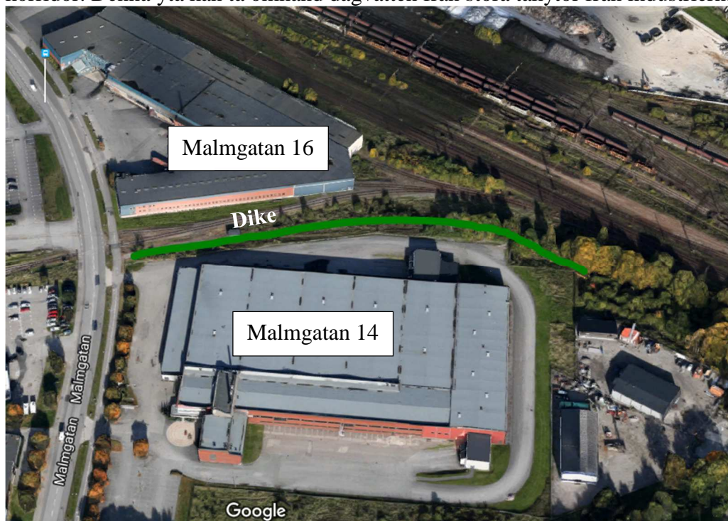
Figur 25) Nytt dike på kommunal mark
