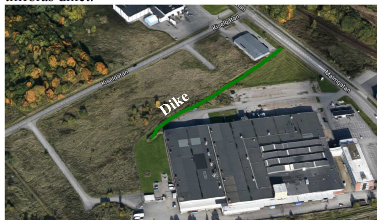
Figur 23) Befintligt dike längsmed Kiselgatan på fastighetsmark
