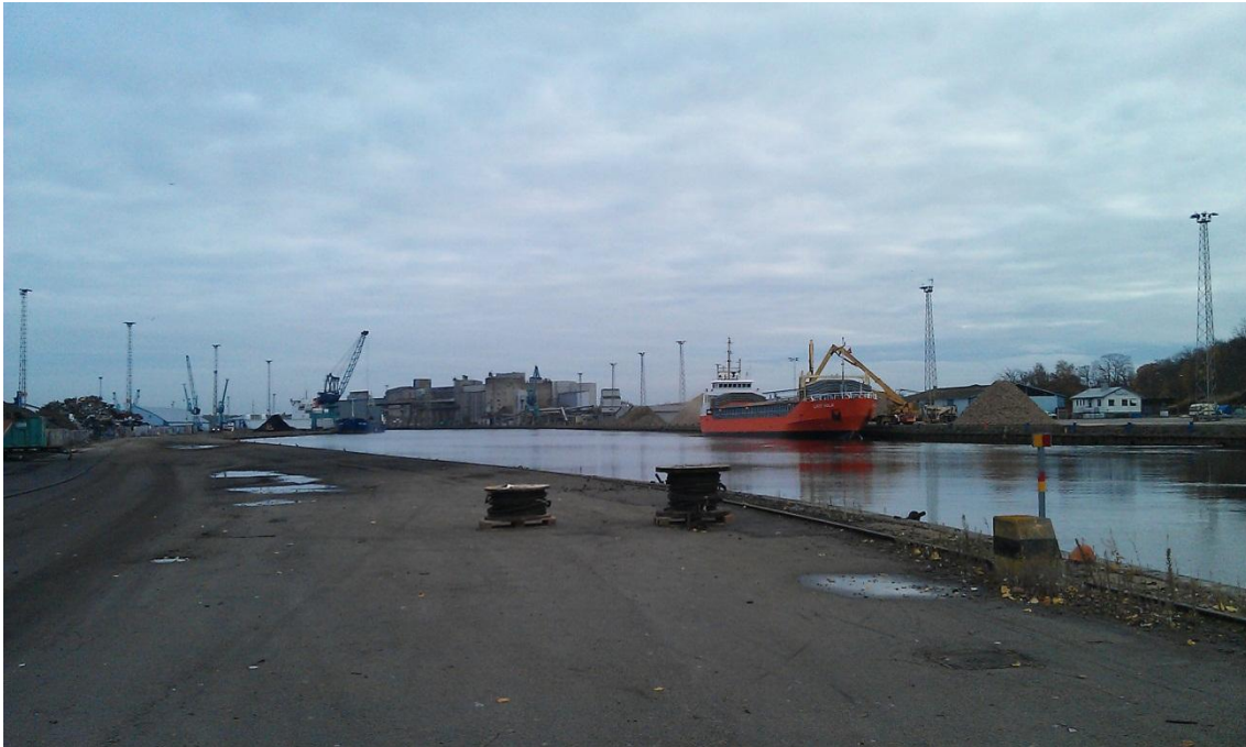
Figur 6. Hamnen. På södra sidan finns Lantmännen med sin lastning av flis. På norra sidan finns idag skrot- och kolhantering.
